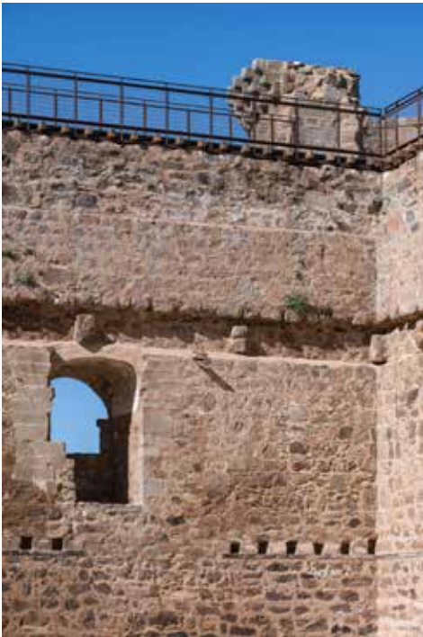
Mechinales y rebajes originales en el muro, reflejando los niveles de las antiguas construcciones perimetrales.
