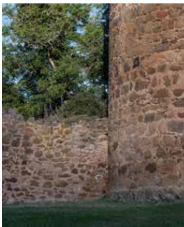
Unión entre la muralla y el cubo noroccidental.
