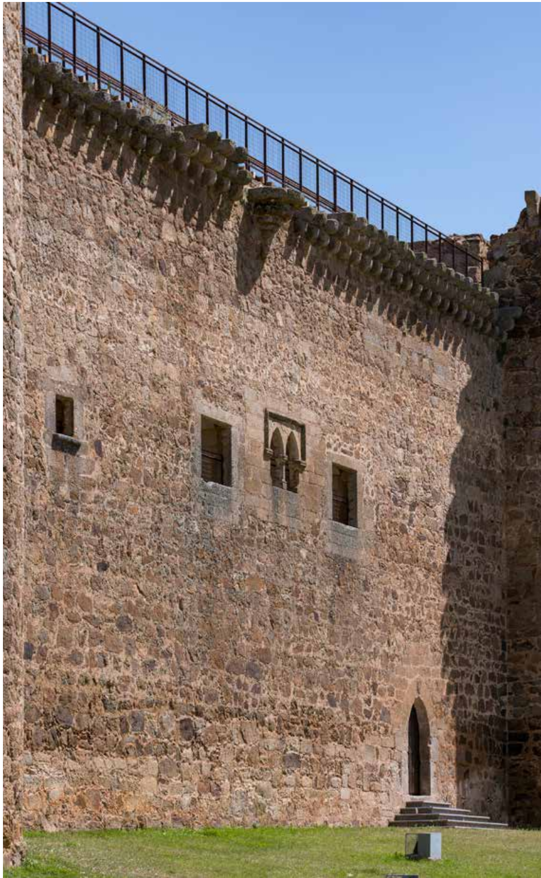
Limpeza de los muros y consolidación del relleno en el adarve.
