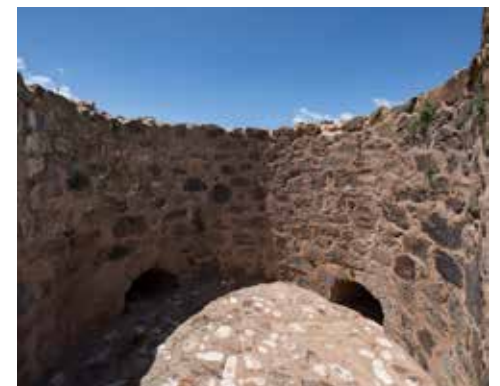
Torres macizas circulares, ubicadas en las esquinas.
