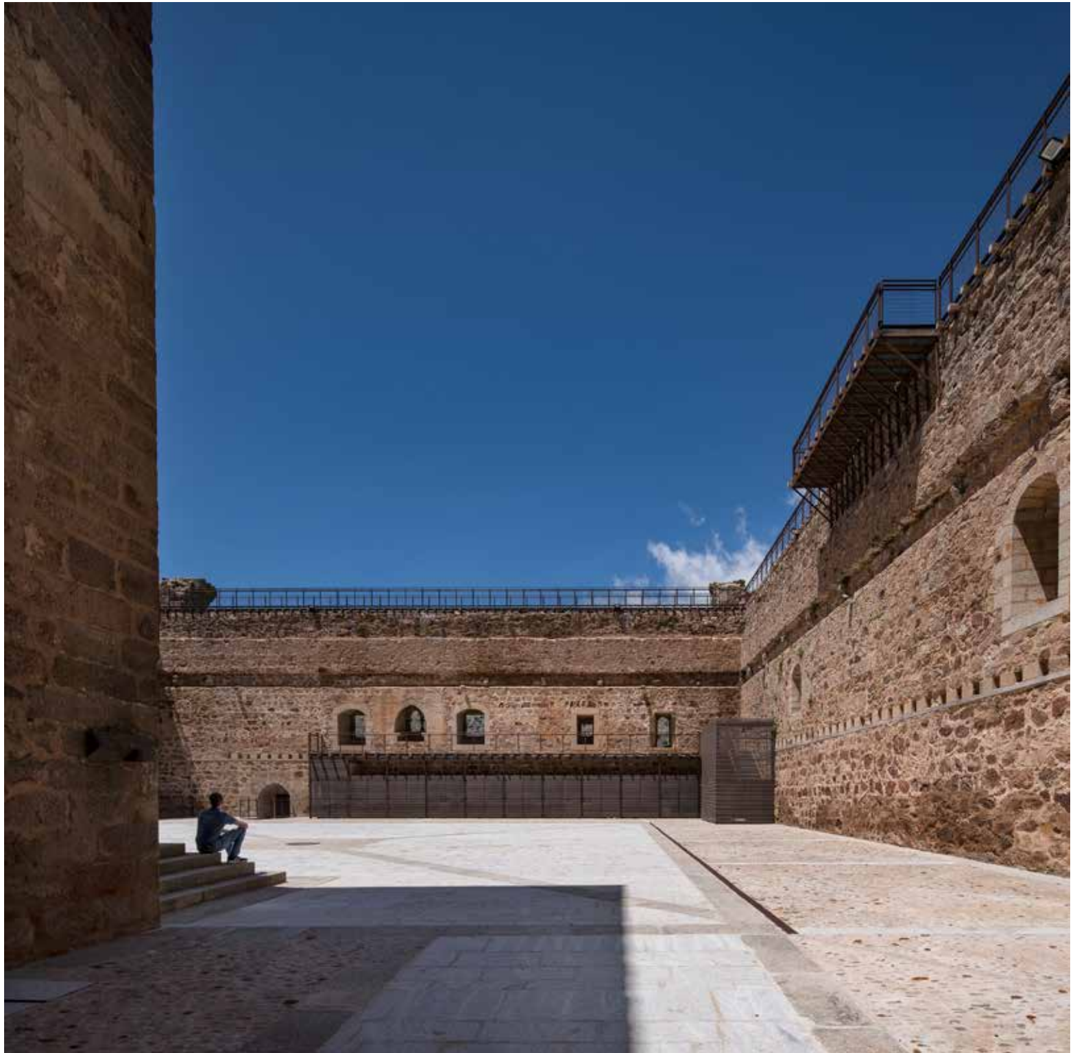
Nuevo pavimento en el patio, representando las antiguas crujías.
