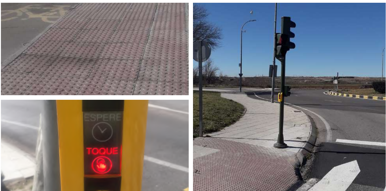
Imagen detalle del pavimento de botones y el pulsador del semáforo
