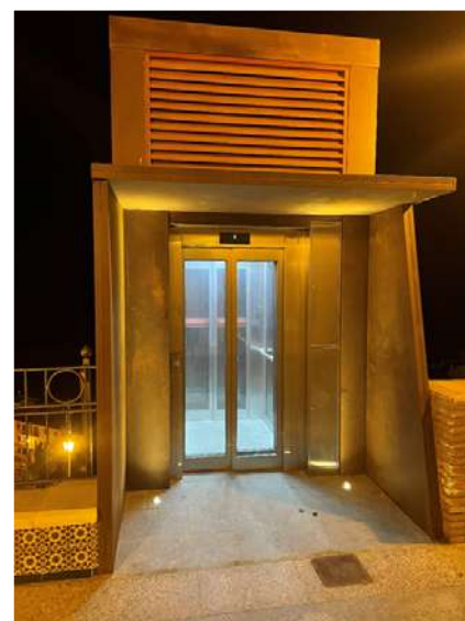
Imagen del acceso a la cabina en la planta superior
