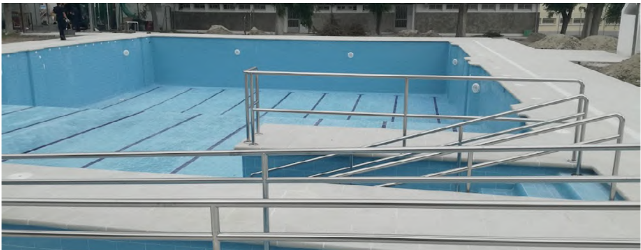
Imagen de la rampa y escaleras de acceso durante la intervención
