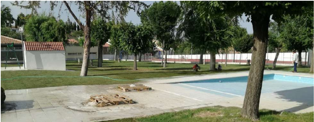
Imagen de la piscina de chapoteo durante la intervención
