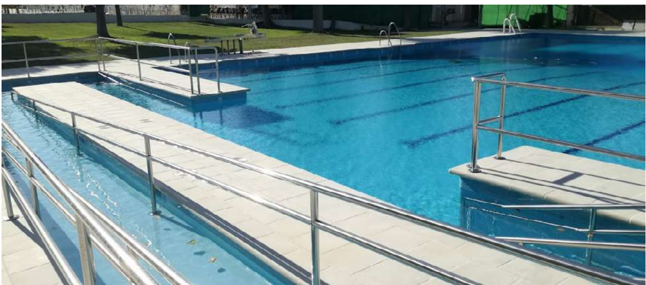
Imagen de la piscina después del llenado
