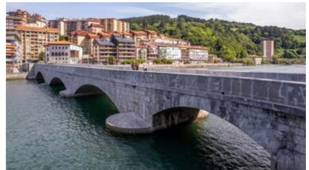
Figura 153. Estado final del puente Deba tras su reparación.
