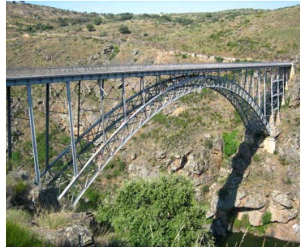
Figura 103. Puente de Pino o de Requejo, 1897-1914. Obra del ing. J. Eugenio Ribera, reconocida por su novedosa estructura, ligereza y elegancia. Cortesía Fundación Miguel Aguiló.
