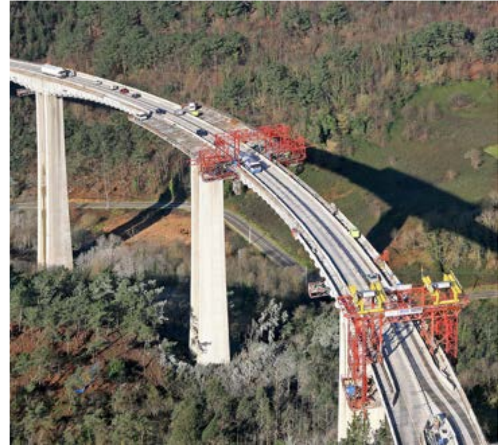
Figura 86. Viaducto de San Pedro de la Ribera
