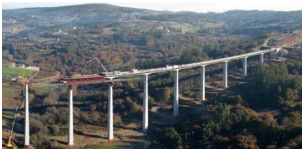
Figura 81. Viaducto do Eixo
