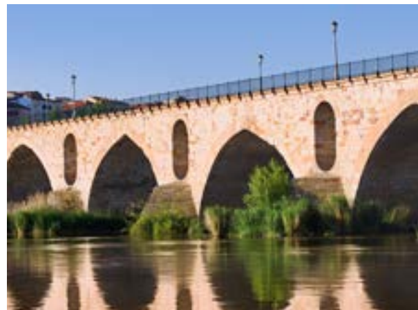
Figura 202. Vista diurna de las pilas del puente de piedra.
