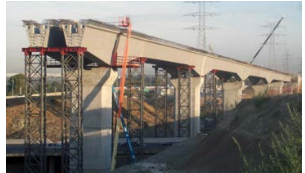
Figura 84. Viaducto de FFCC sobre la M-40
