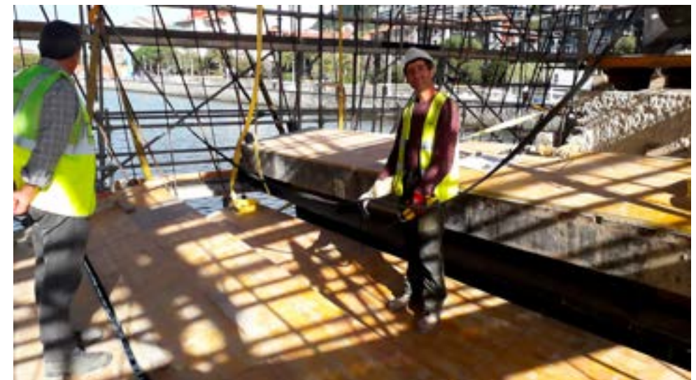
Figura 151. Elevación de los encofrados a la nueva posición corregida.
