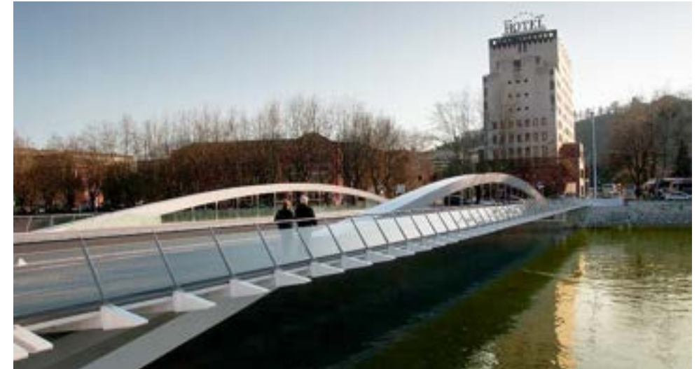
Figura 21. Puente Lehendakari Aguirre, vistas aguas abajo. San Sebastián
