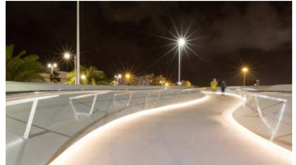
Figura 30. Camino nocturno. Vista superior de la pasarela.
