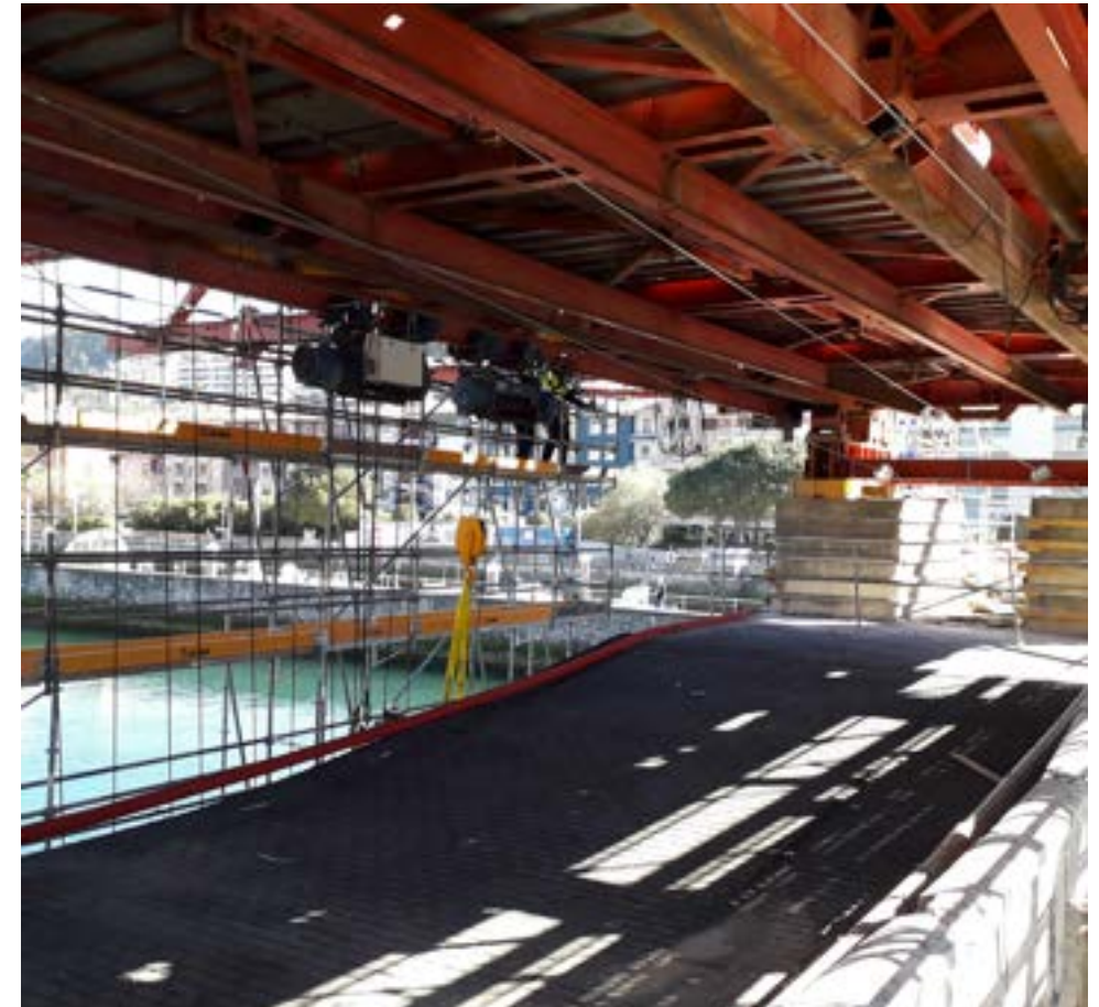
Figura 140. Polipastos de izado de los paños.
