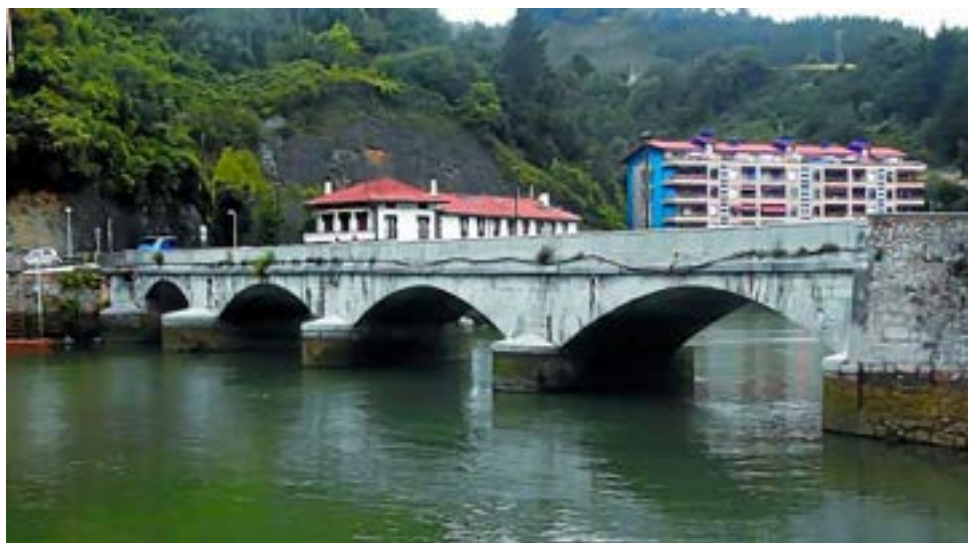
Figura 128. Puente Deba, antes de sufrir problemas estructurales.
