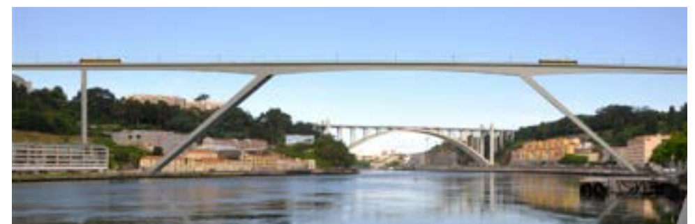
Figura 33. Algunas propuestas del concurso del puente del metro de Oporto sobre el río Duero
