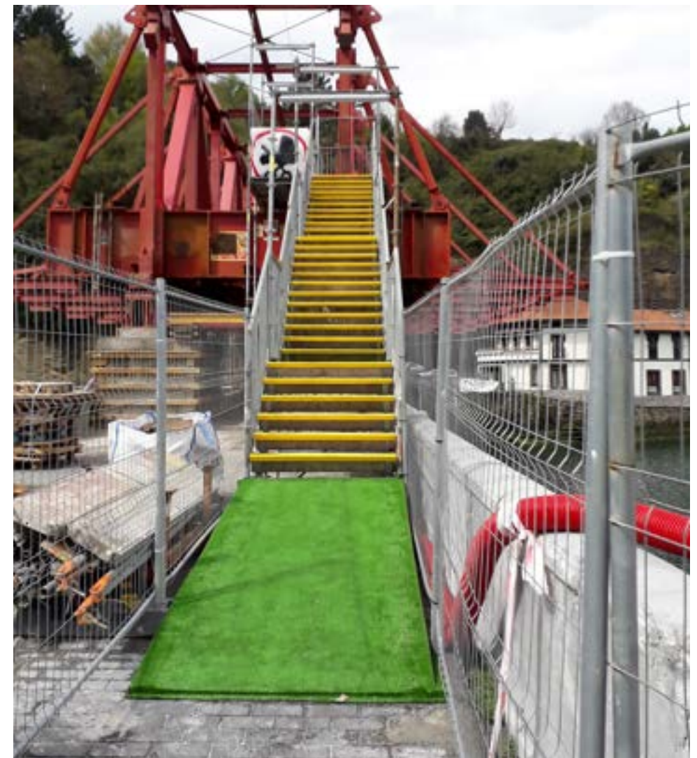
Figura 145. Escalera auxiliar de acceso peatonal.
