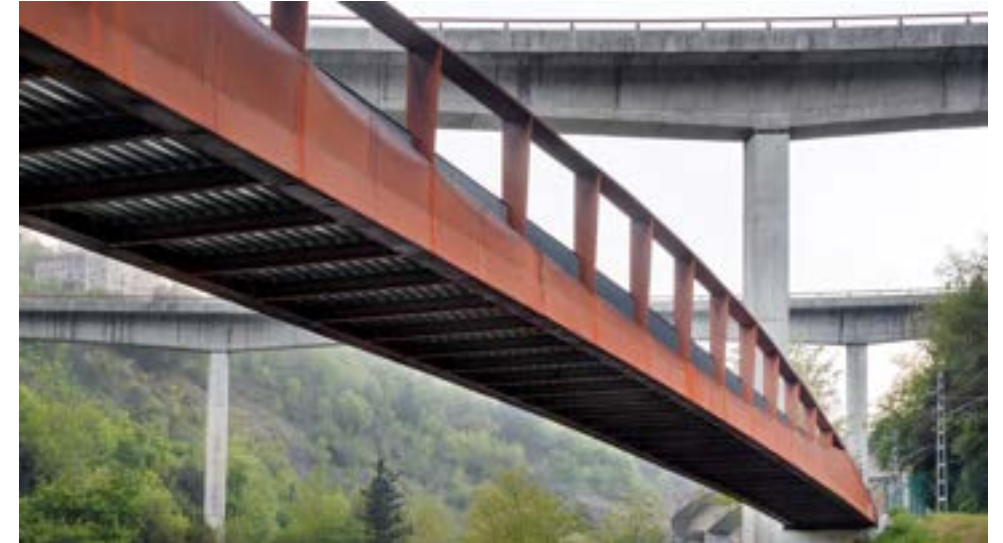
Figura 43. Pasarela sobre el río Deva
