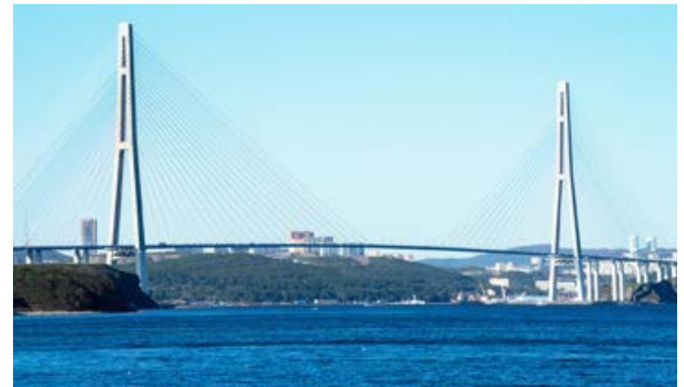
Figura 168. Puente de Russky, 1.104 m de luz.
