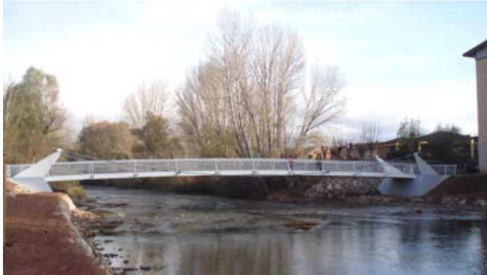
Figura 50. Pasarela de Nájera
