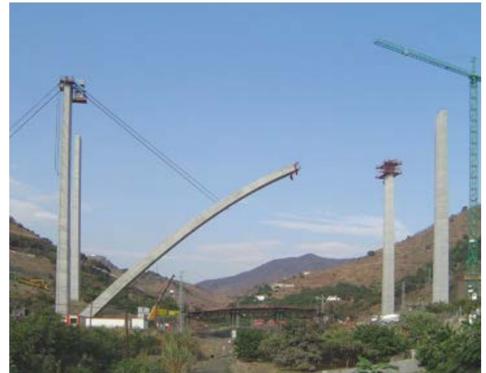
Figura 75. Viaducto sobre el Barranco de La Cuesta Teixeira
