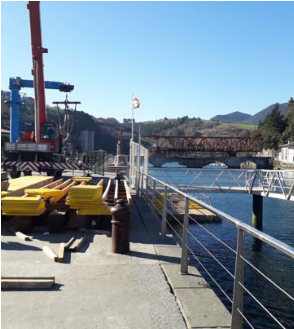
Figura 136. Premontaje de los paños en el puerto marítimo deportivo.
