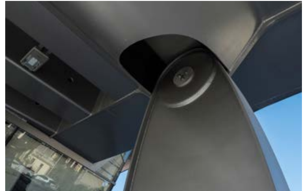
Figura 114. Viaducto Estación de Loyola, proyectado por ANTA INGENIERÍA CIVIL (fotos Xavier Font 2017)
