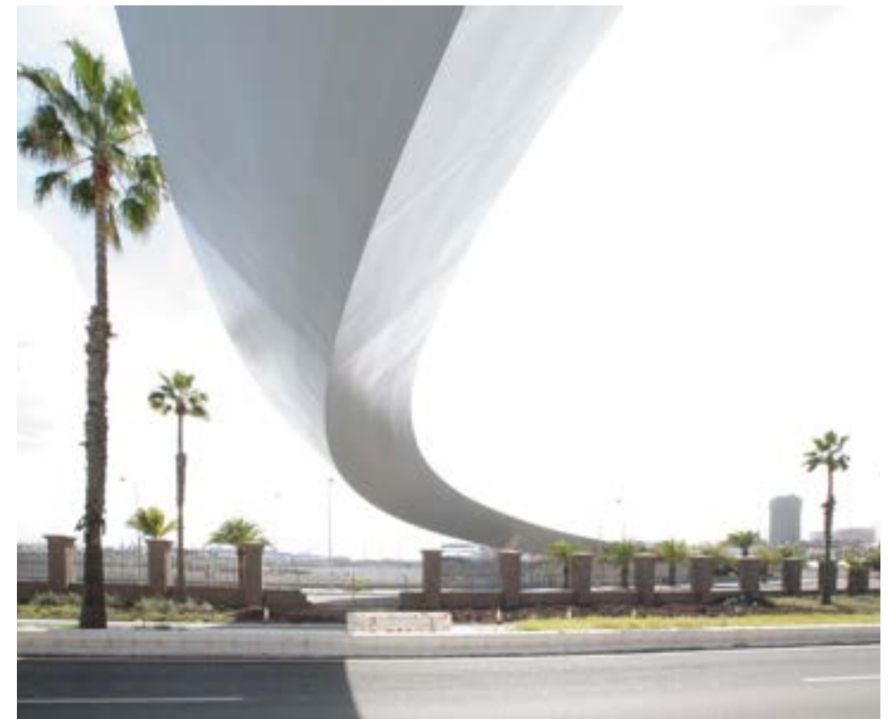
Figura 31. Vista inferior de la pasarela.
