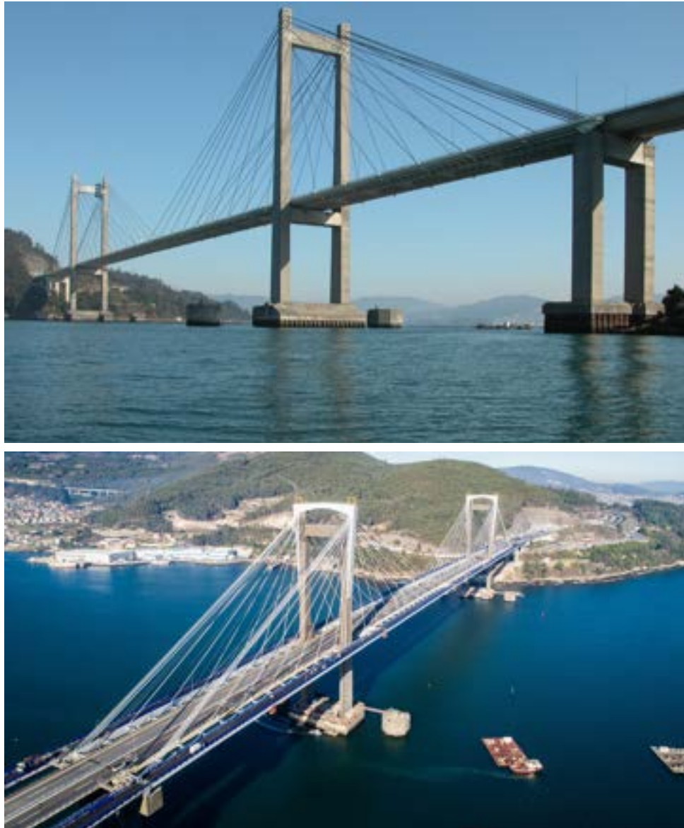
Figura 12. Puente de Rande antes y después del ensanche del tablero y nueva instalación de familias de tirantes.
