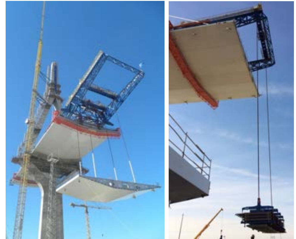
Figura 183. Izado de dovelas (izquierda) y losas (derecha) durante la construcción del Puente de Cádiz.
