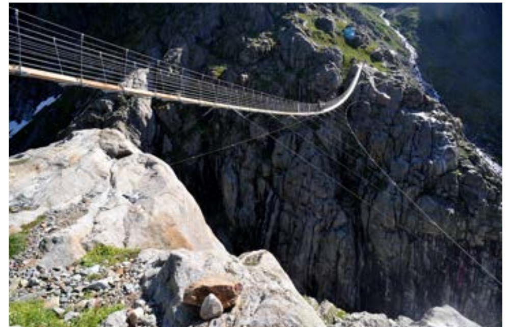
Figura 119. Pasarela del Trift en Suiza (foto Xprouna 2009, Wikimedia Commons)
