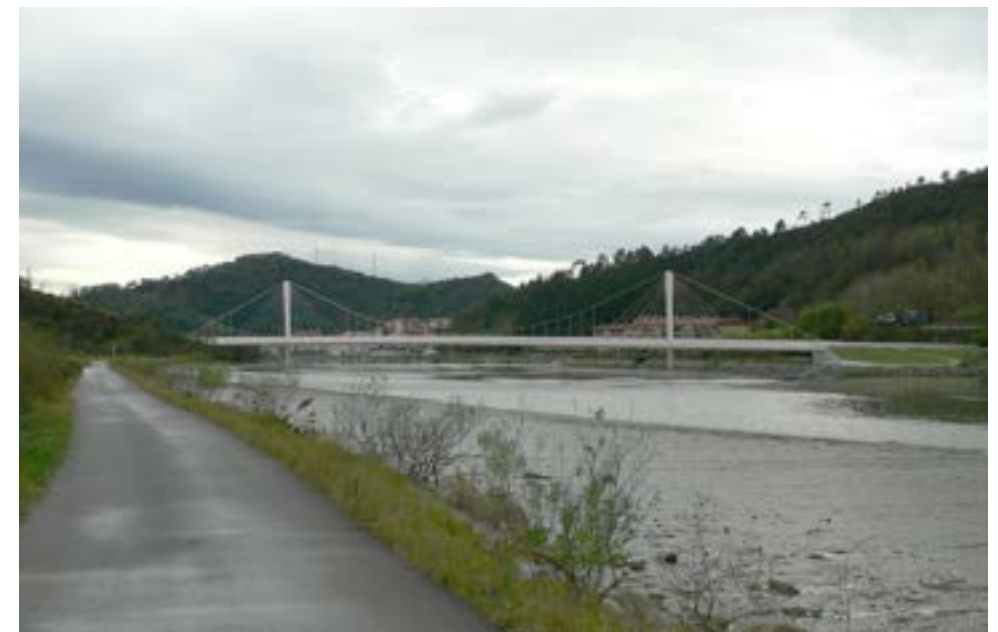
Figura 49. Puente de Orío, Guipúzcoa
