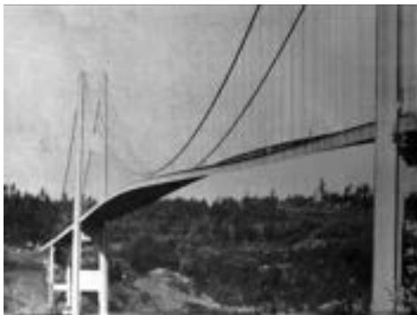
Figura 192. Puente de Tacoma. Comienzo de resonancia.
