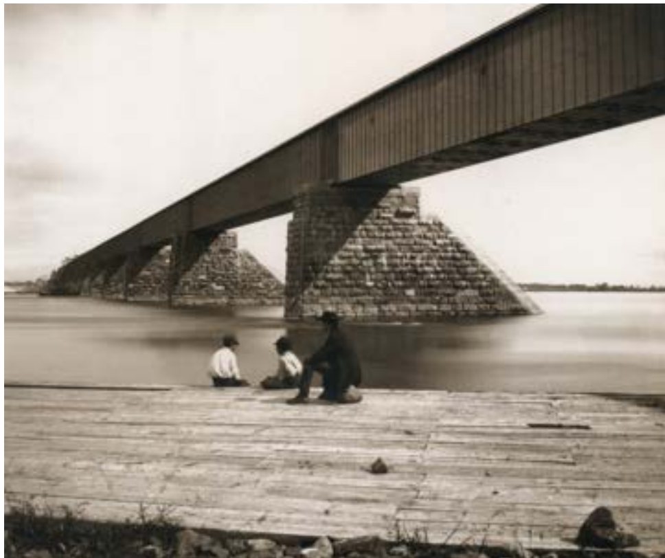
Figura 90. Puente Victoria sobre el río San Lorenzo, Montreal (ferrocarril Grand-Trunk). Ing. R. Stephenson, 1859. Archivo: 92 William England.
