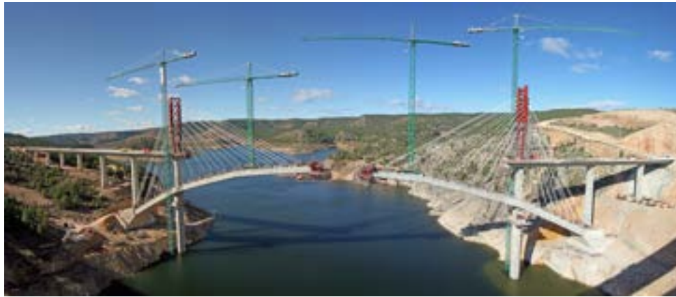
Figura 73. Viaducto sobre el embalse de Contreras
