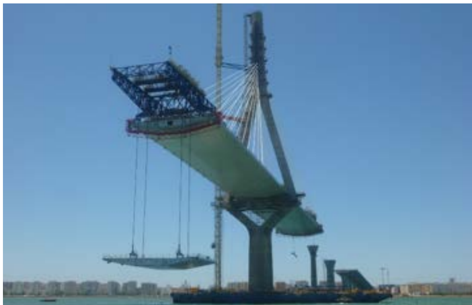
Figura 186. Carros de izado de dovelas empelados en el Forth (arriba) y Cádiz (abajo)
