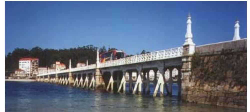
Figura 16. Puente de la Toja (1999) antes de la intervención.
