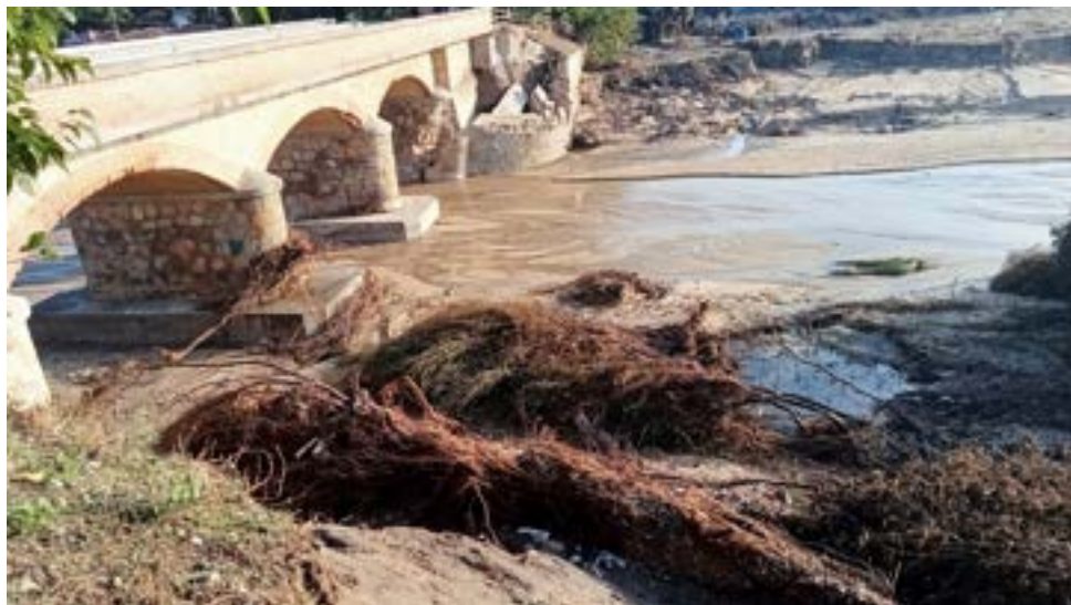
Figura 213. Detalle de fase de obra.
