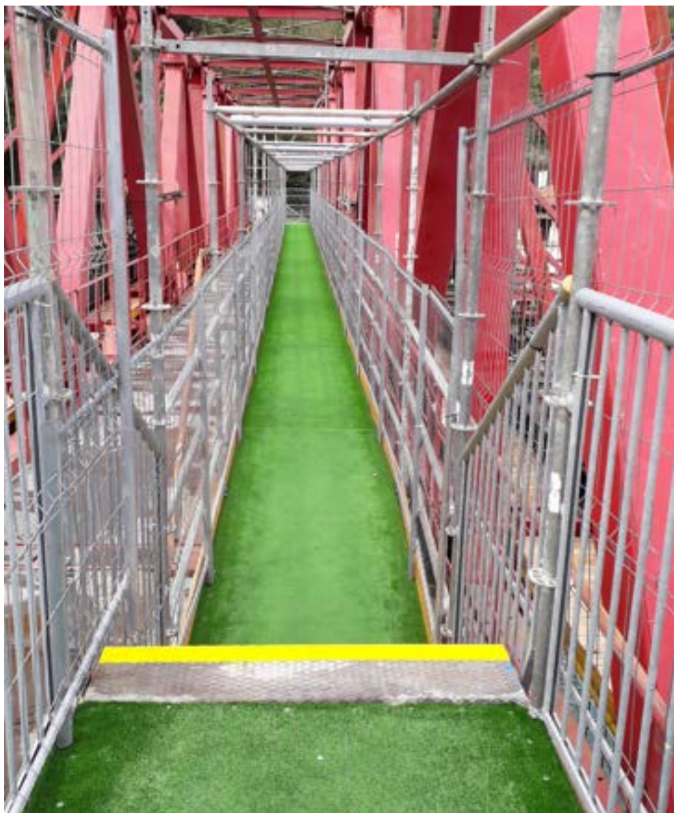
Figura 146. Pasillo de la pasarela peatonal por el interior de la autocimbra.
