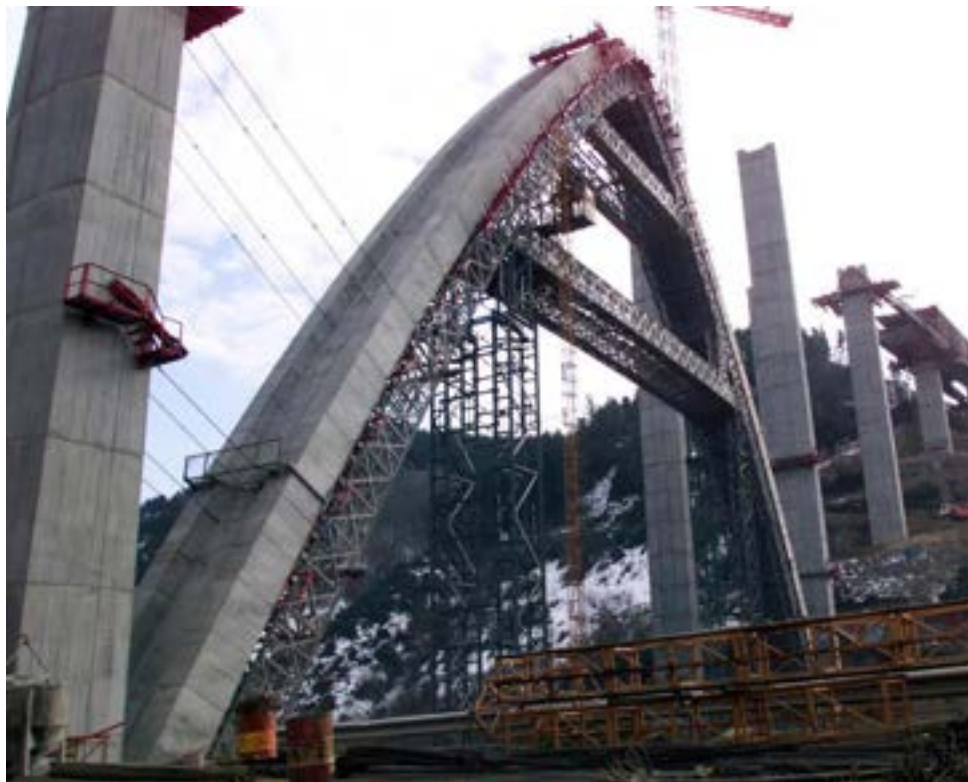
Figura 71. Viaducto sobre el río Narón
