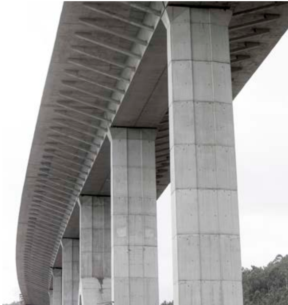
Figura 83. Viaducto de Barayo
