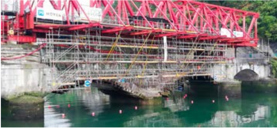
Figura 141. Proceso de vaciado y retirada de tímpanos.
