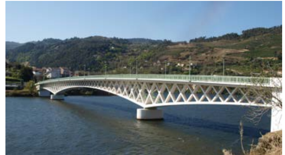
Figura 57. Puente de Mosteiró. Ingeniero Edgar Cardoso
