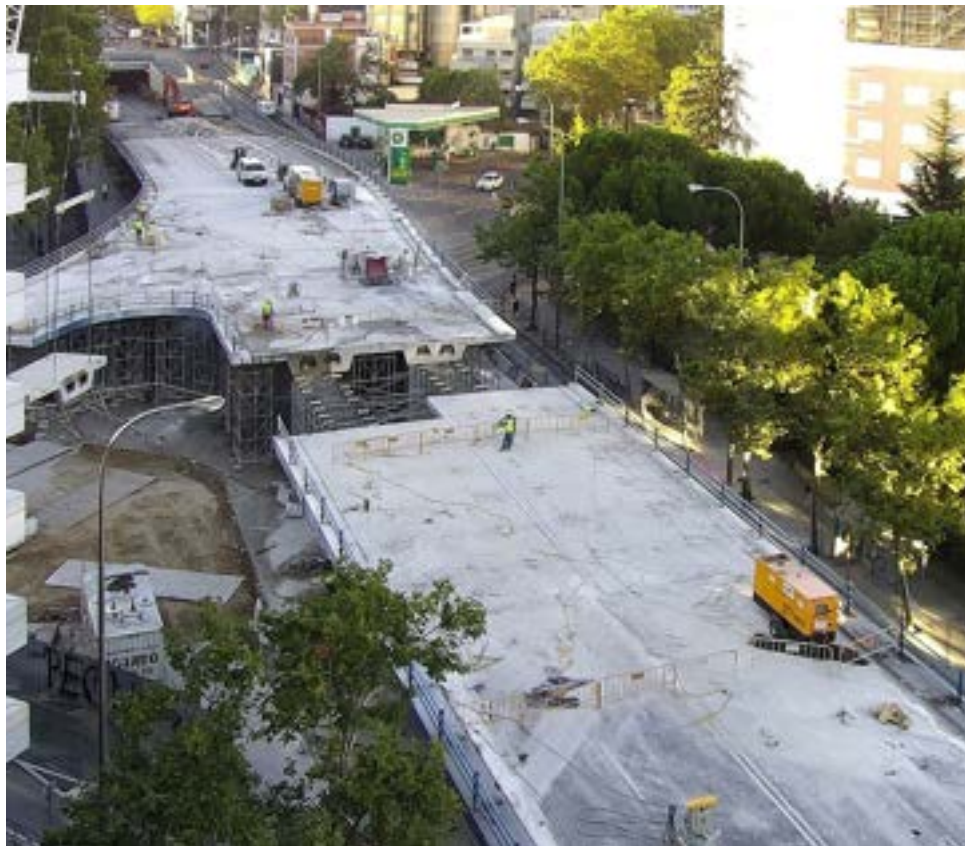
Figura 18. Desmontaje del paso superior Joaquín Costa - Francisco Silvela (Madrid, 2020). Foto cortesía de DRAGADOS.
