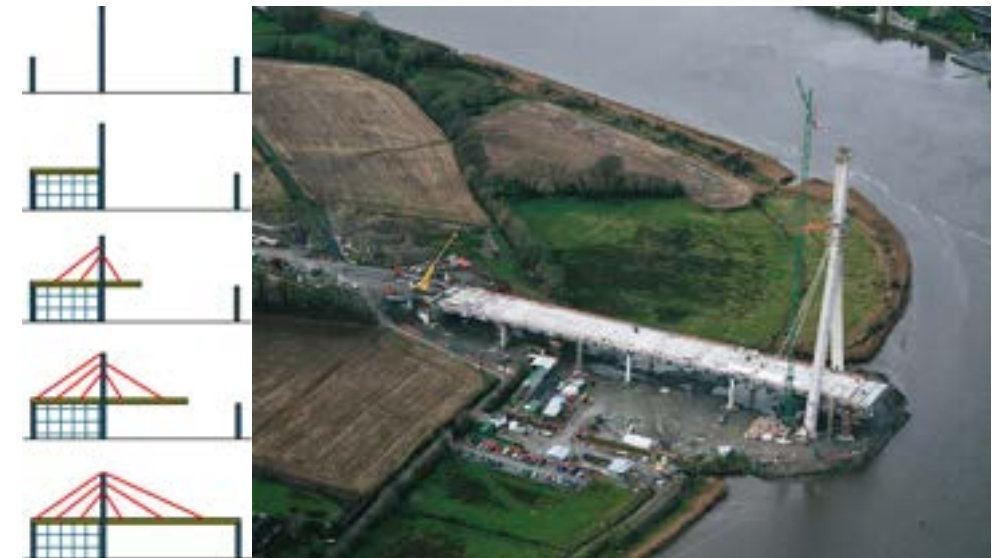
Figura 173. Construcción con vano trasero apeado (izquierda). Puente sobre el río Suir, Waterford (derecha)
