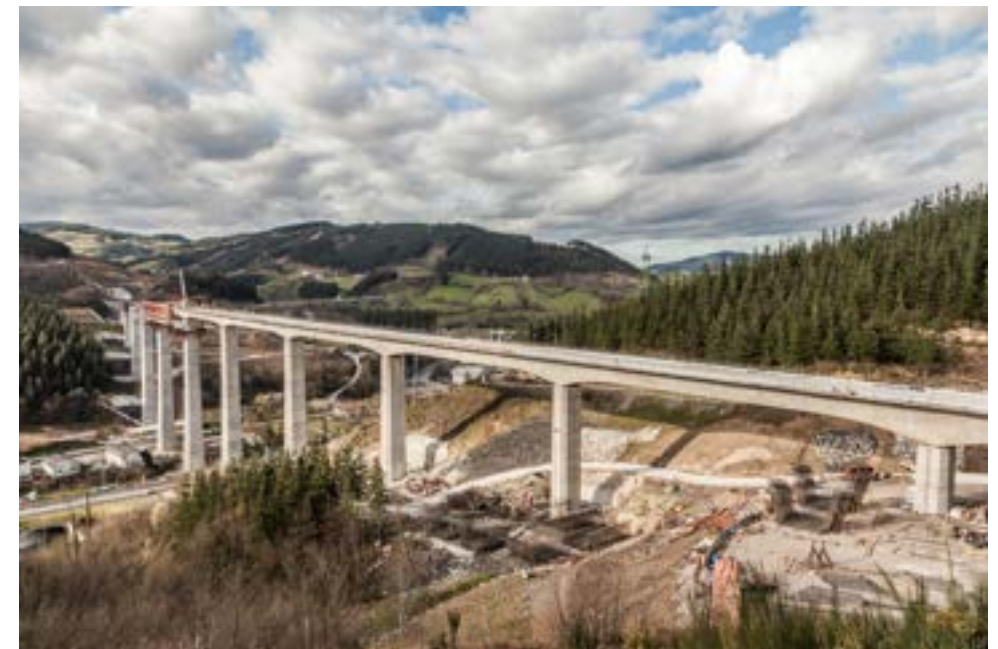
Figura 82. Viaducto sobre el río Deba
