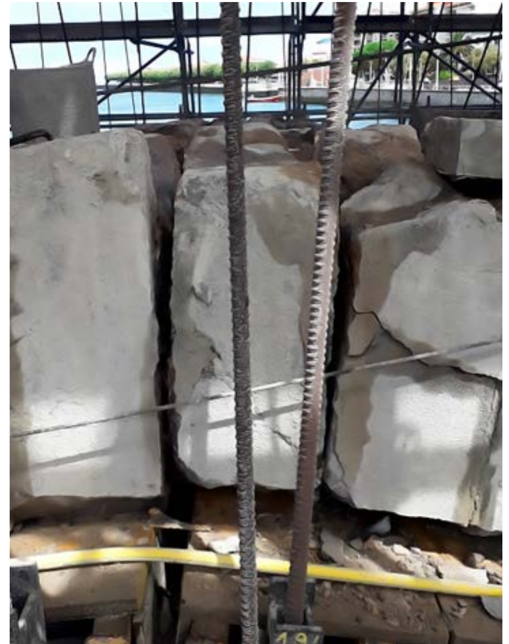
Figura 143. Momento de apertura de la clave.
