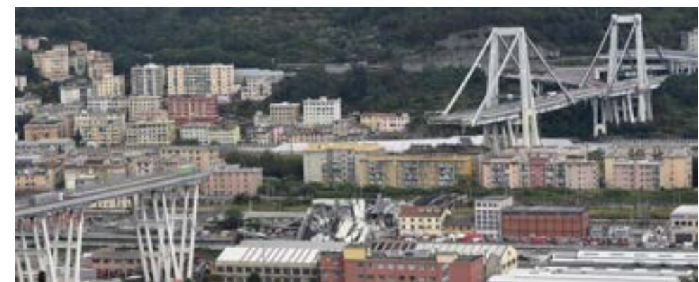
Figura 6. Colapso del puente Polcevera (Morandi). Génova, 14 de agosto de 2018.
