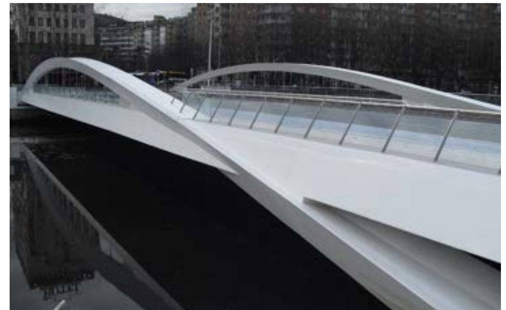
Figura 22. Puente Lehendakari Aguirre, vistas aguas arriba. San Sebastián.
