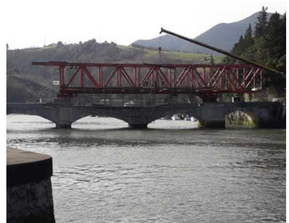
Figura 131. Cimbra autolanzable CA55 apoyada sobre pila P1 y pila P3.
