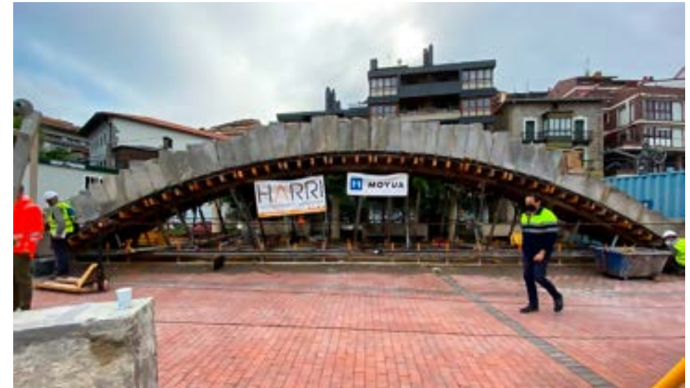
Figura 150. Arco en funcionamiento tras el montaje en blanco.
