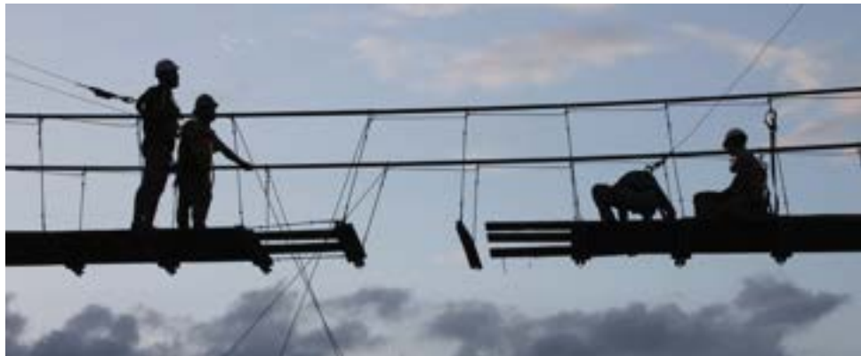
Figura 126. B2P - Pasarela en Monte Verde, Nicaragua (foto Fhecor 2017)
