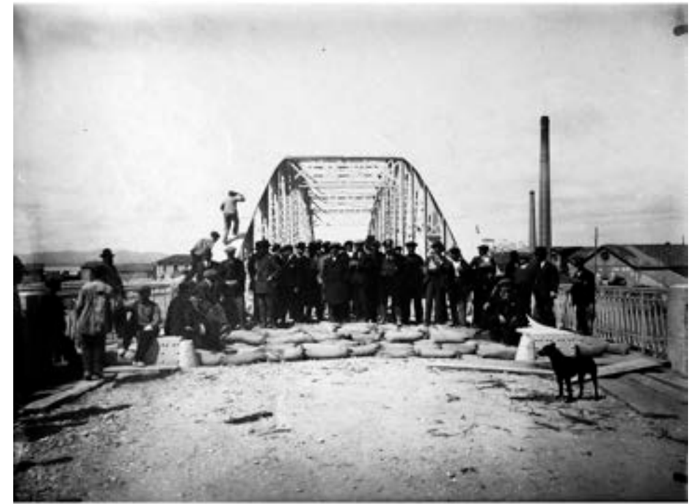
Figura 92. Prueba de carga en el puente sistema Bow-string, sobre el río Júcar en Alzira, 1917. Cortesía Cátedra Demetrio Ribes.
