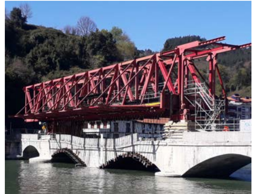
Figura 137. Paños de encofrado ya instalados.
