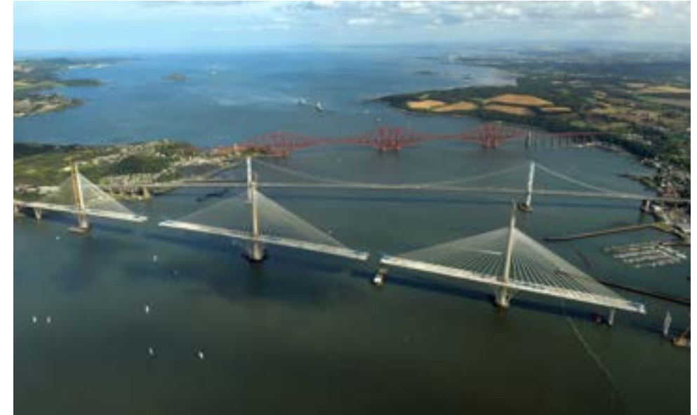
Figura 185. Construcción del Queensferry Crossing, Escocia, Reino Unido.
