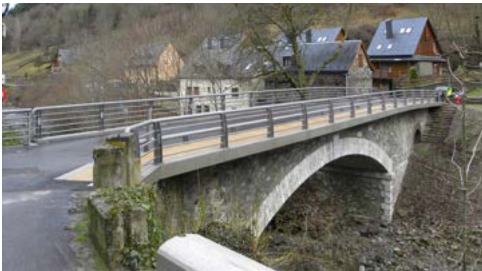
Figura 208. Vista del puente de Aubert.
