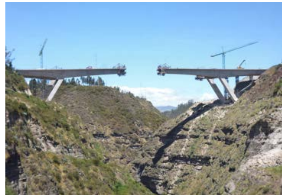
Figura 77. Viaducto sobre el río Chiche
