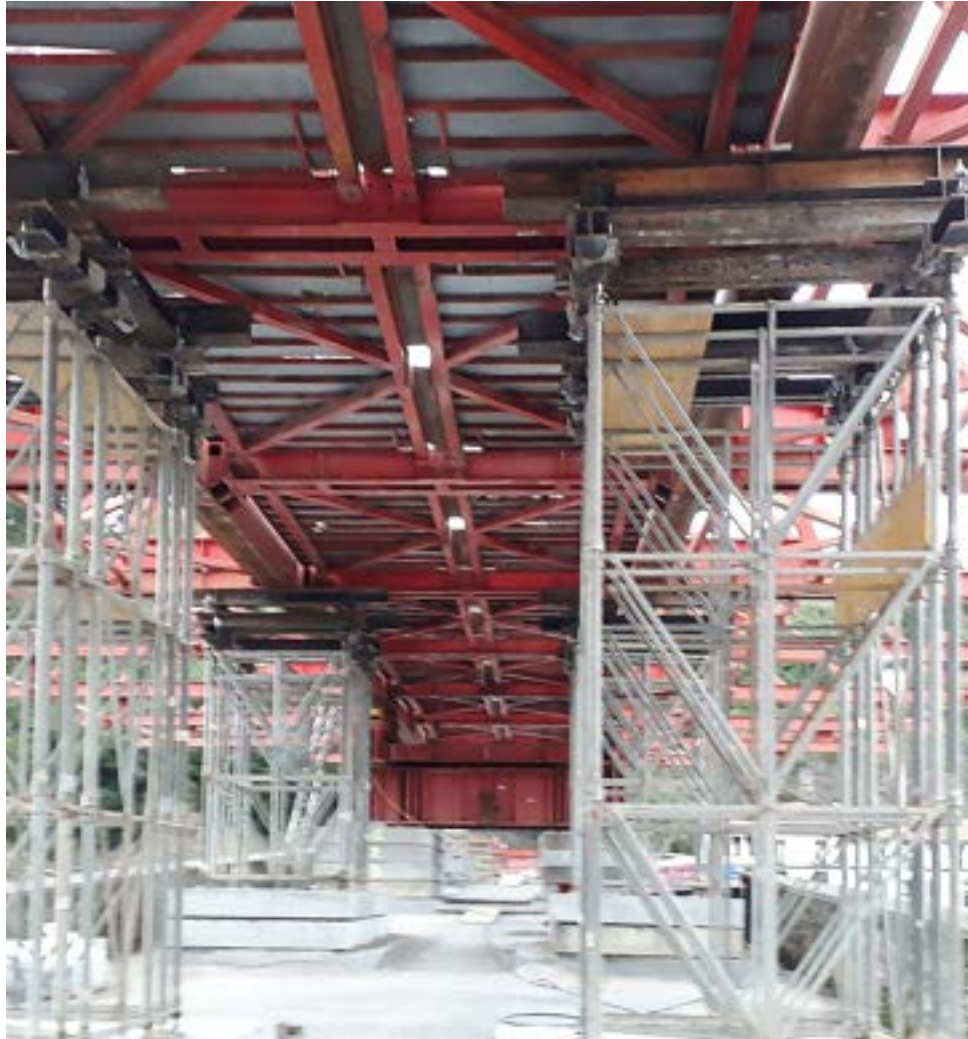
Figura 132. Cimbra autolanzable CA55 sobre torres de cimbra OC durante su montaje.
