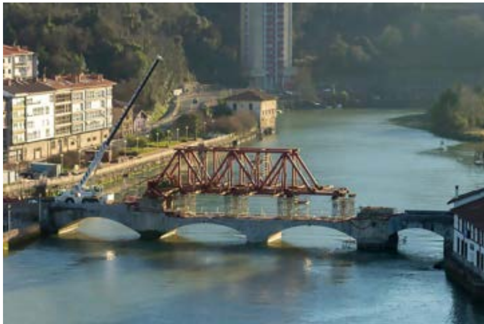
Figura 152. Desmontaje de la cimbra autolanzable sobre torres de cimbras OC auxiliares.
