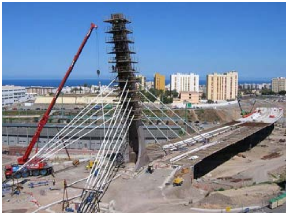
Figura 172. Construcción viaducto de Escaleritas, Las Palmas de Gran Canaria.
