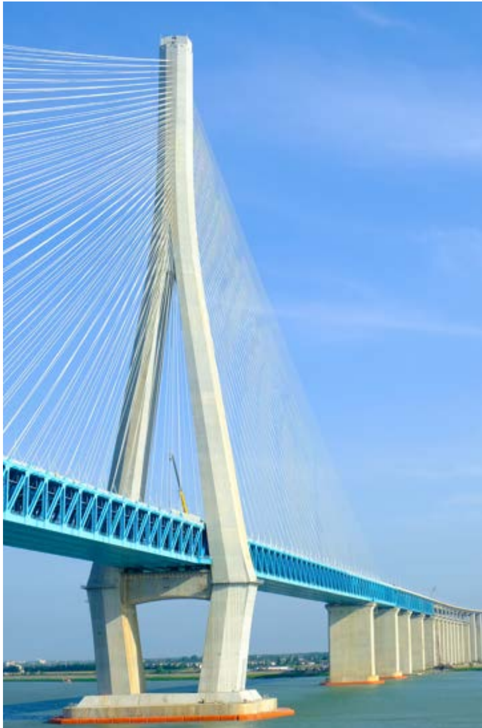
Figura 169. Puente de Sutong, 1088 m de luz.
