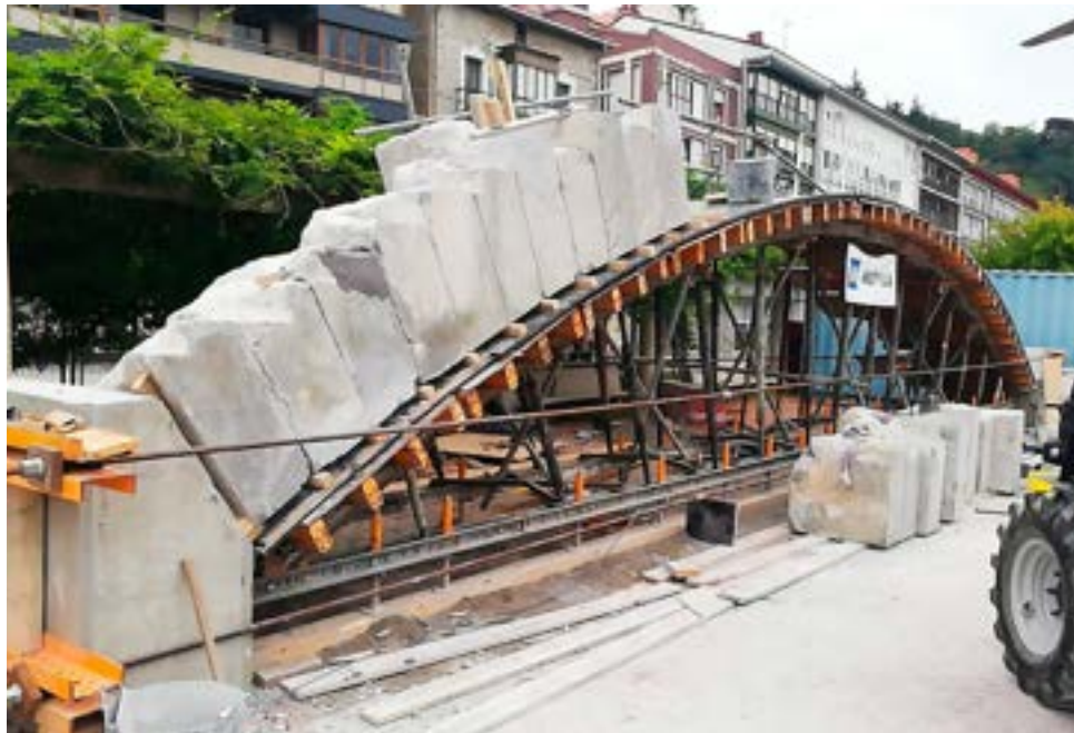
Figura 149. Colocación de dovelas en el montaje en blanco.
