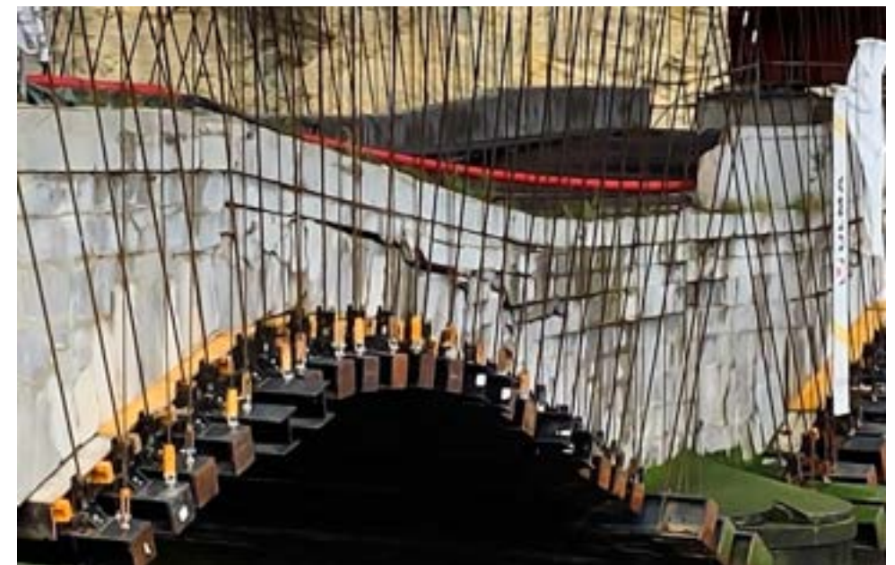
Figura 138. Abanicos de barras Dywidag de suspensión de los encofrados.
