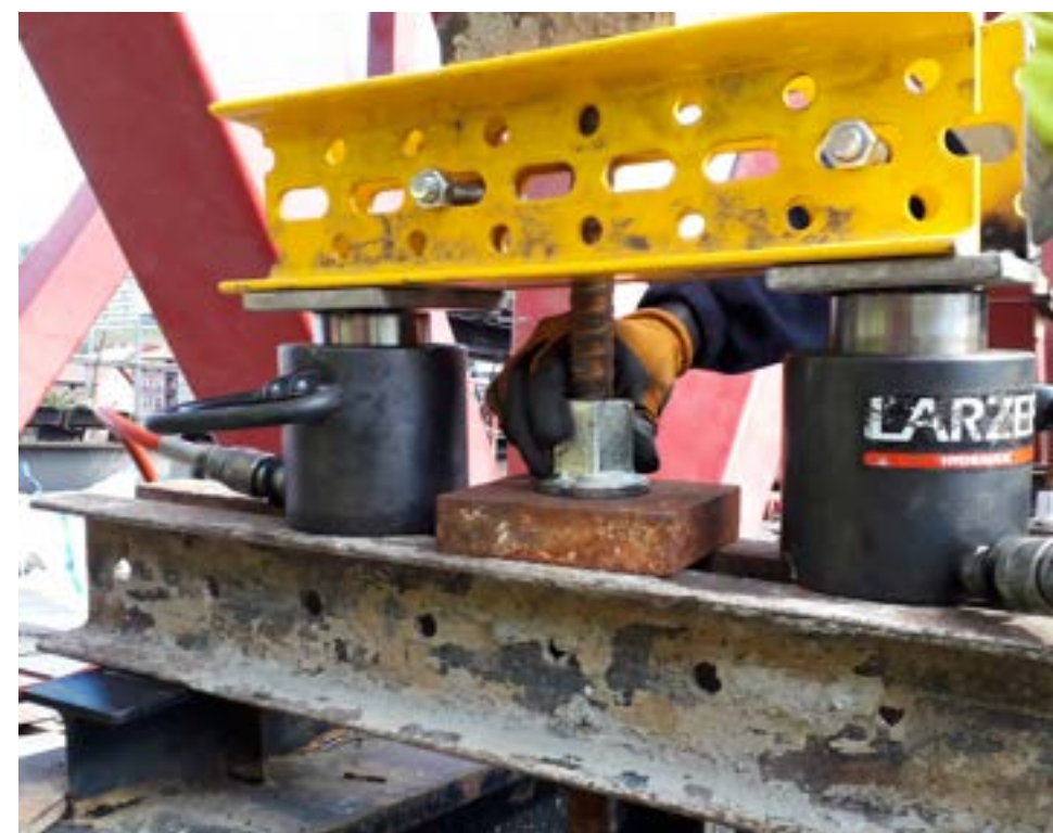
Figura 148. Pesaje de una de las barras.
