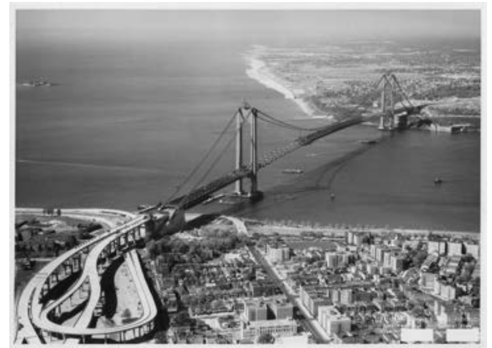
Figura 220. Vista aérea del Puente Verrazano Narrows.
