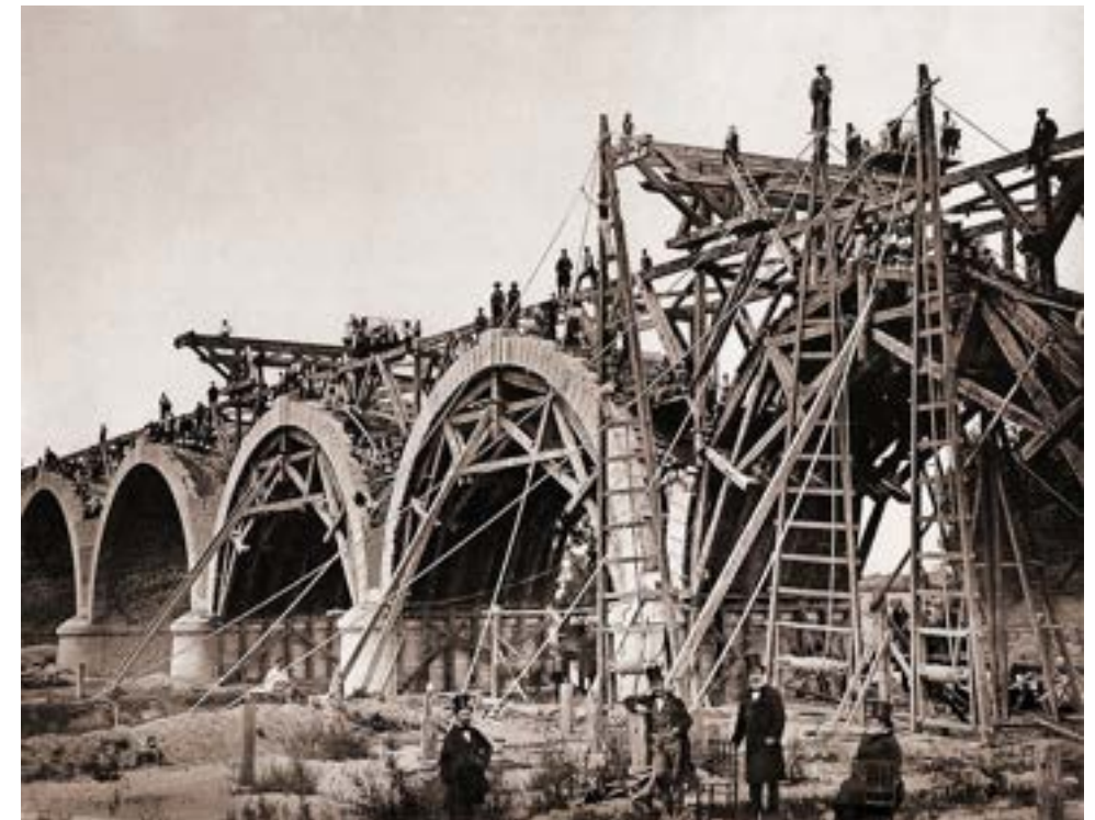
Figura 68. Cimbra del puente de los Franceses
