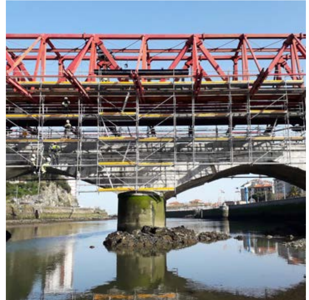
Figura 133. Cimbra autolanzable CA55 con andamio multidireccional instalado.
