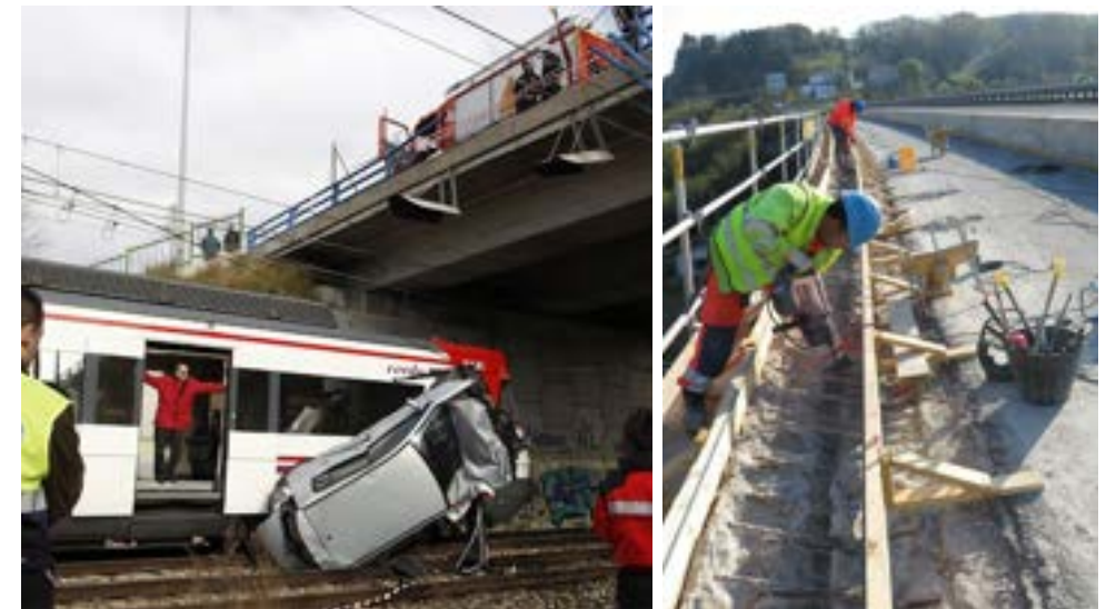
Figura 10. Izquierda, accidente (sin víctimas mortales aunque las consecuencias podrían haber sido dramáticas al poner en riesgo la seguridad de los usuarios del ferrocarril) con fallo del sistema de contención de vehículos en el tablero del paso superior. Derecha, actuación en el viaducto de Asti (Zarauz, Guipúzcoa) para anclar reglamentariamente el sistema de contención de vehículos.
