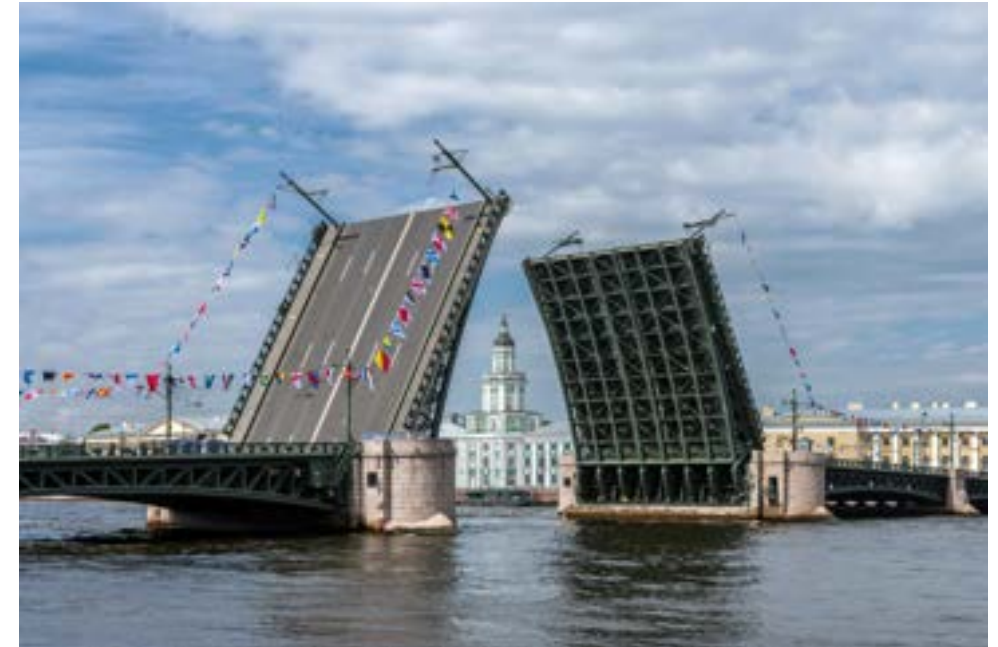
Figura 222. El puente del Palacio, escenario de la secuencia de Octubre.
