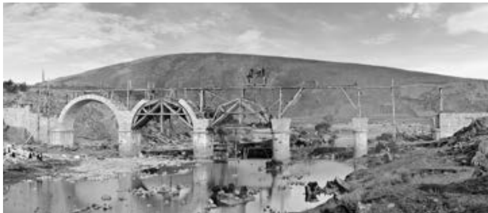
Figura 3. Fotografía de Jean Laurent del puente sobre el río Tera. A la bóveda de la izquierda, ya descimbrada, sigue otra aún construyéndose sobre cimbra y una tercera con cimbra en proceso de montaje. A la derecha, las bóvedas cuyas primeras hiladas se mantienen gracias al rozamiento entre éstas. Por encima, la pasarela auxiliar para el transporte de dovelas y otros materiales.
