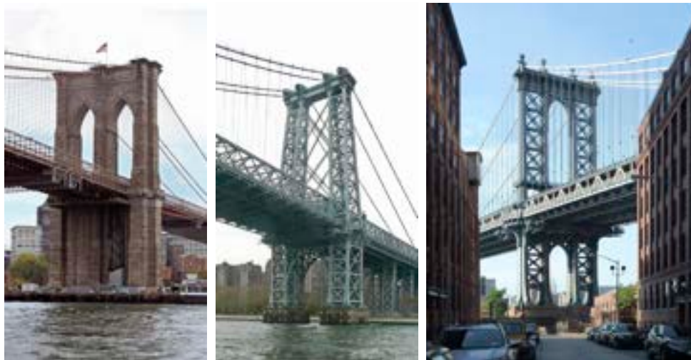
Figura 62. Puentes de Brooklyn, Williamsburg y Manhattan, New York
