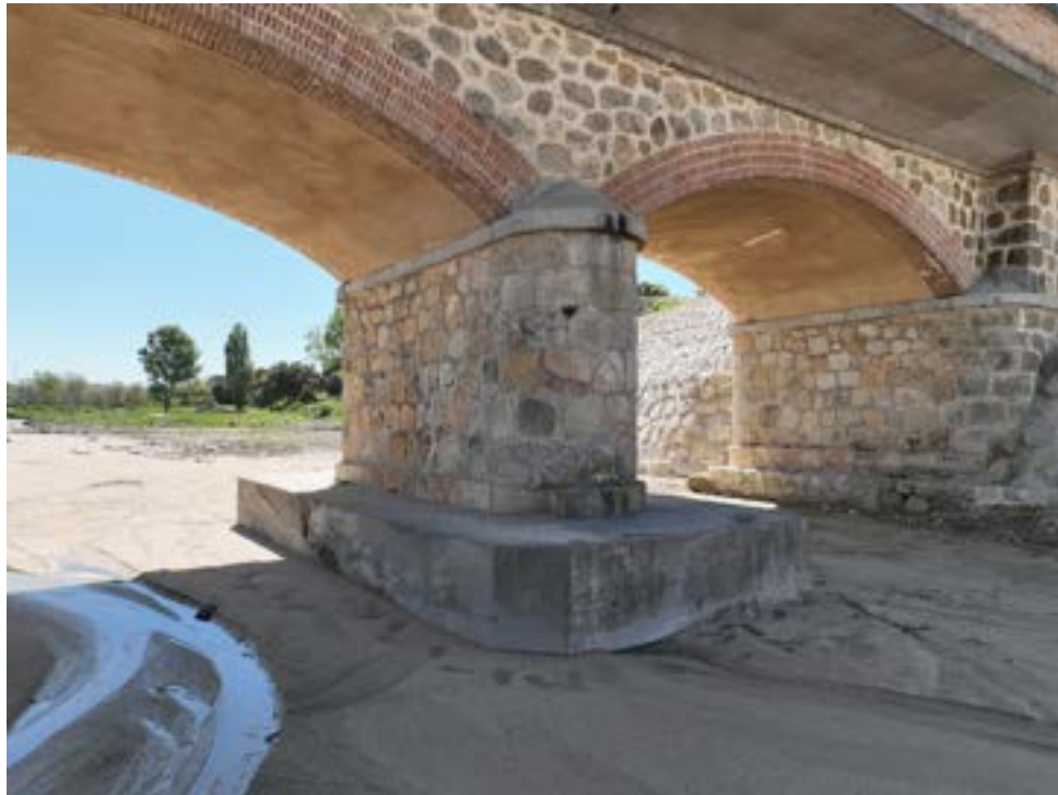
Figura 212. Vista del puente de Villamanta.
