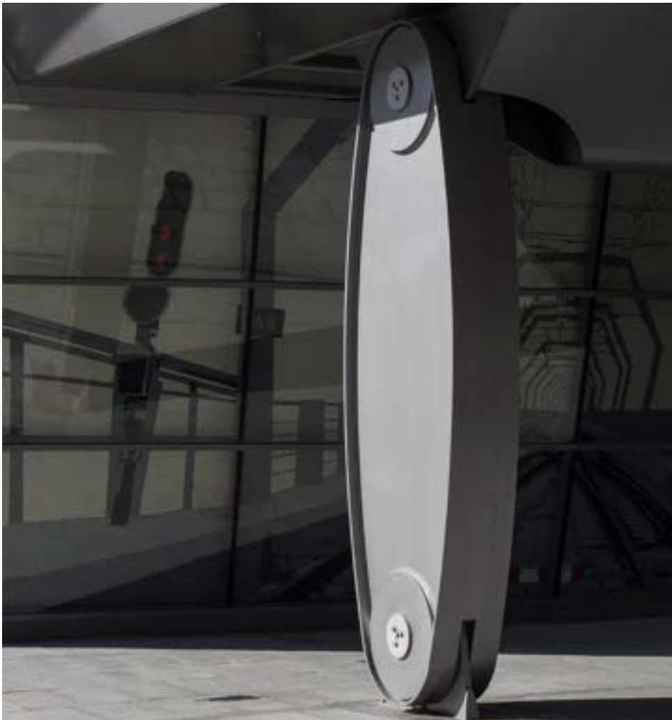
Figura 114. Viaducto Estación de Loyola, proyectado por ANTA INGENIERÍA CIVIL (fotos Xavier Font 2017)
