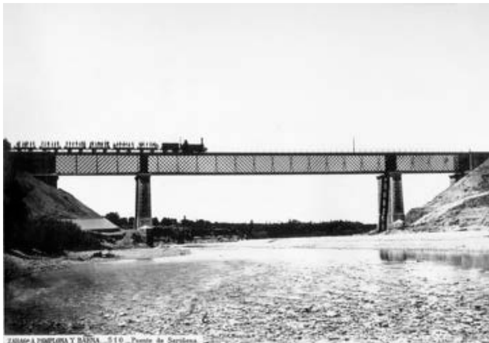
Figura 89. Puente de Sariñena, ferrocarril Zaragoza a Pamplona y Barcelona. Fot. J. Laurent (1858-1870). Archivo de la Demarcación de Carreteras del Ministerio de Fomento, Ciudad Real.
