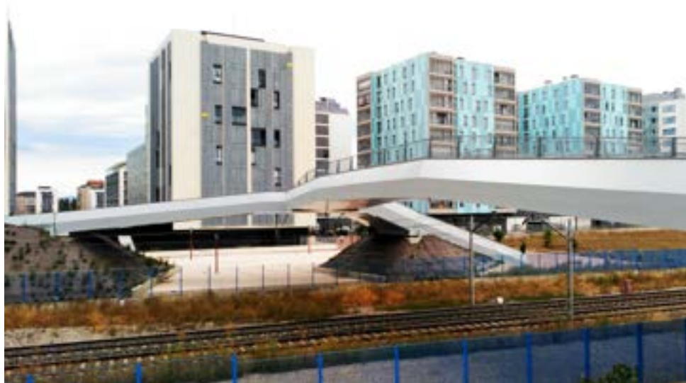
Figura 45. Pasarela de Zabalzana
