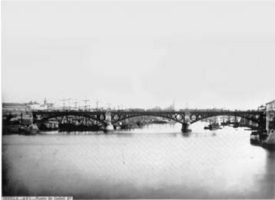
Figura 91. Puente de Isabel II, Sevilla. Se adopta el modelo del ingeniero Polonceau del puente Carrousel, París. Fot. J. Laurent (1858-1870). Archivo de la Demarcación de Carreteras del Ministerio de Fomento, Ciudad Real.
