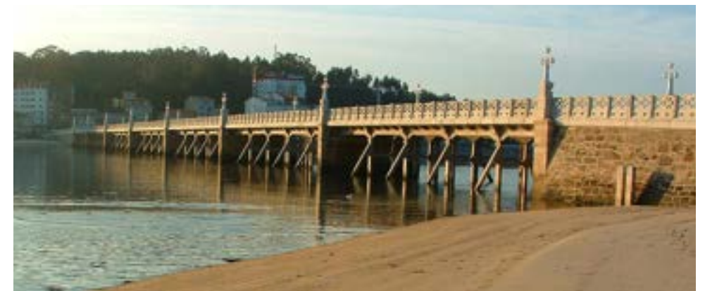
Figura 17. Puente de la Toja tras la intervención de 2002-2003.
