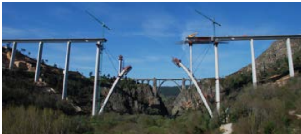
Figura 74. Viaducto sobre el río Ulla
