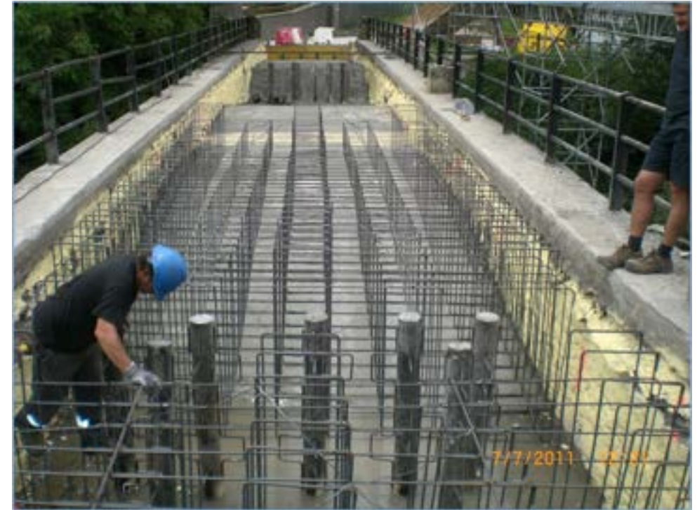
Figura 209. Detalle de fase de obra.
