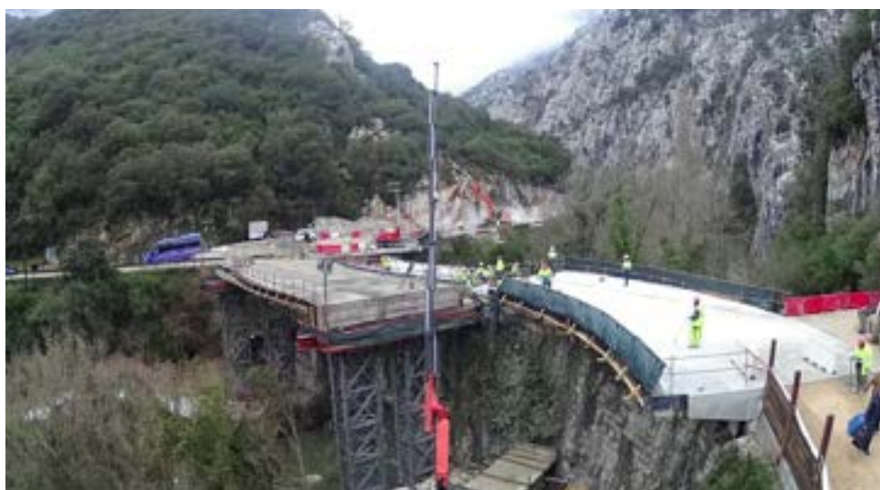
Figura 88. Ampliación sobre bóveda en el Desfiladero de La Hermida
