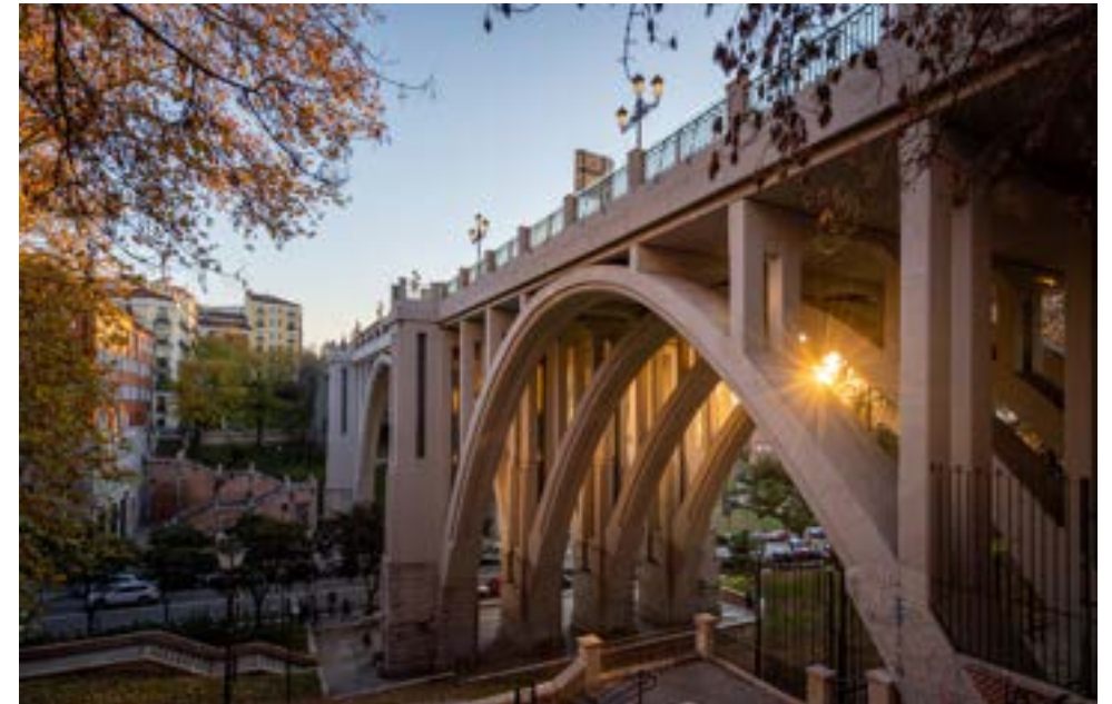
Figura 205. Vista diurna lateral del viaducto actual sobre la calle Bailén, en Madrid.
