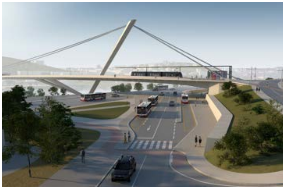
Figura 51. Puente en Dvorecky, Praga
