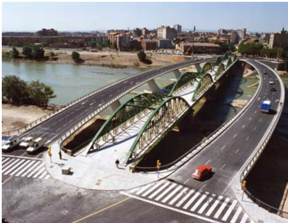
Figura 104. Puente de hierro en Zaragoza o puente de Ntra. Sra. del Pilar. En 1991 el ingeniero Javier Manterola se encarga de la restauración del puente, repara su estructura y añade dos tableros laterales en forma de arco para el tráfico rodado. Cortesía Fundación Miguel Aguiló.
