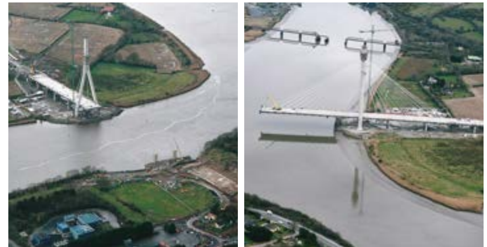
Figura 177. Construcción del Puente sobre el río Suir, Waterford (Irlanda) 2009.
