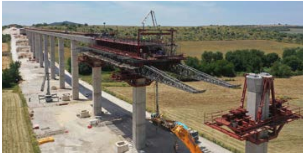
Figura 80. Viaducto sobre la Ribera de Can Cao
