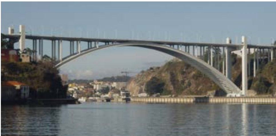
Figura 32. Puente de la Arrábida. Ingeniero Edgar Cardoso
