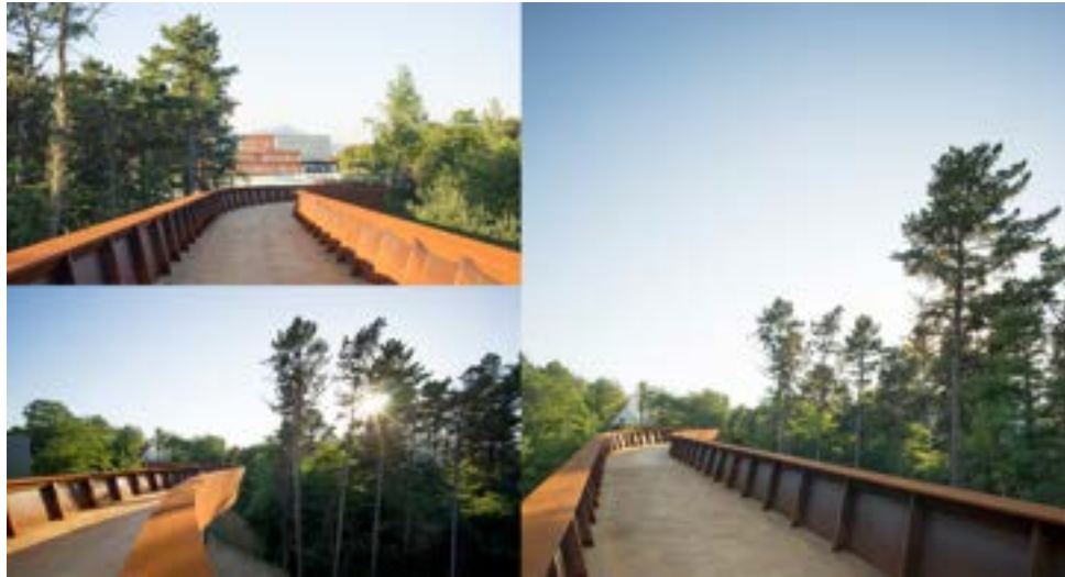
Figura 27. Interior de la Pasarela Miramón.
