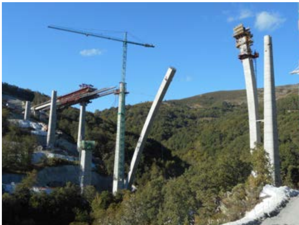
Figura 76. Viaducto de Teixeiras
