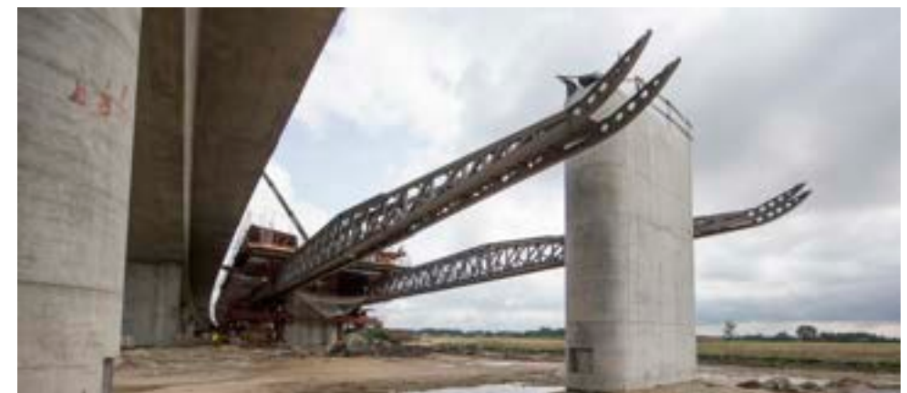
Figura 79. Viaducto ES 5.5 (Polonia)
