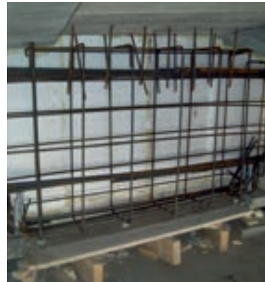
Figura 211. Detalle de fase de obra.
