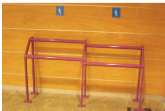
Figura 167. Apoyo isquiático de dos alturas en el Hospital de Getafe. Fuente: Socytec (fotografía).
