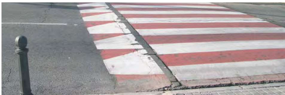
Figura 88. Vados de transición en elevación de la calzada. Fuente: Socytec (fotografía).
