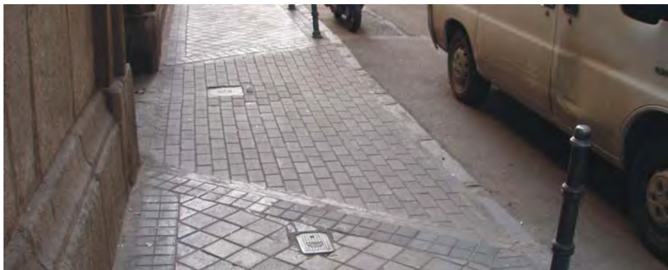
Figura 94. Vado para vehículos. Fuente: Socytec (fotografía).
