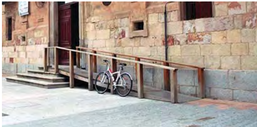
Figura 280. Rampa de madera que facilita el acceso a un edificio de carácter histórico monumental.
