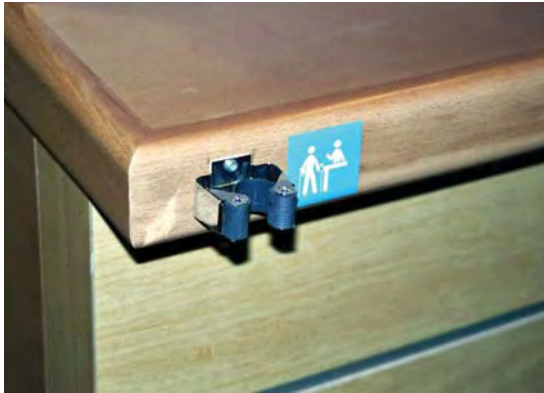
Figura 164. Detalle de una pieza para la sujeción de bastones y su pictograma explicativo. Fuente: Socytec (fotografía).
