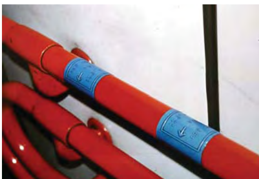
Figura 277. Señalización de pasamanos en braille y alto relieve.
