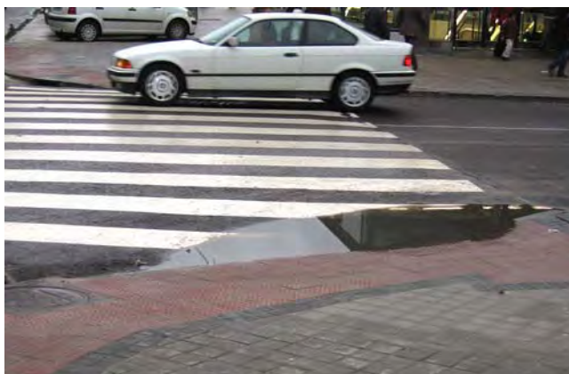
Figura 78. Vado peatonal encharcado por mala evacuación de pluviales. Fuente: Socytec (dibujo).
