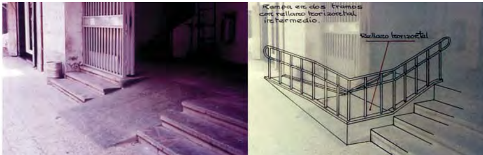
Figura 261. Rampa de excesiva pendiente y mal ejecutada. A la derecha, alternativa correcta mediante una rampa en dos tramos a 90° con meseta horizontal intermedia. Fuente: Socytec (fotografía y dibujo).
