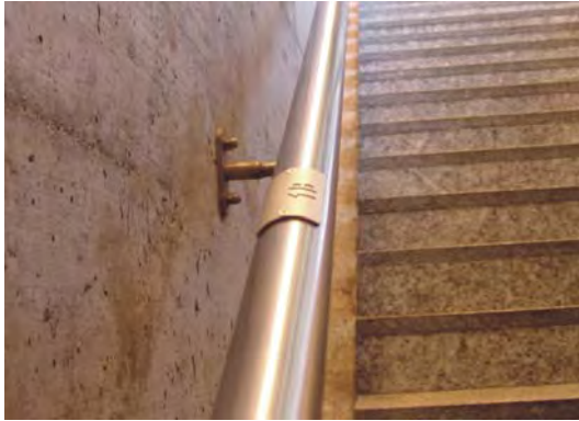
Figura 303. Señalización de pasamanos en Braille y en alto-relieve. Fuente: Socytec (fotografía).
