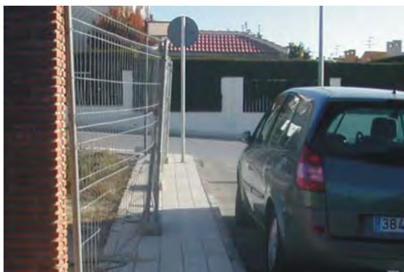
Figura 145. Práctica mejorable: protección de obra invadiendo la acera. Fuente: Socytec (fotografía).
