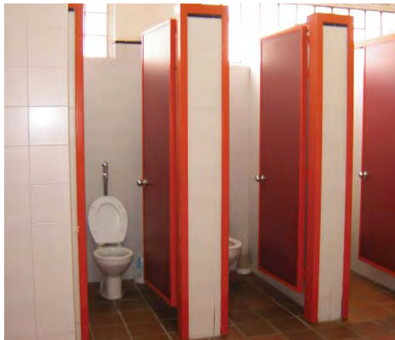
Figura 258. Aseos de instalaciones deportivas. Fuente: Socytec (fotografía).
