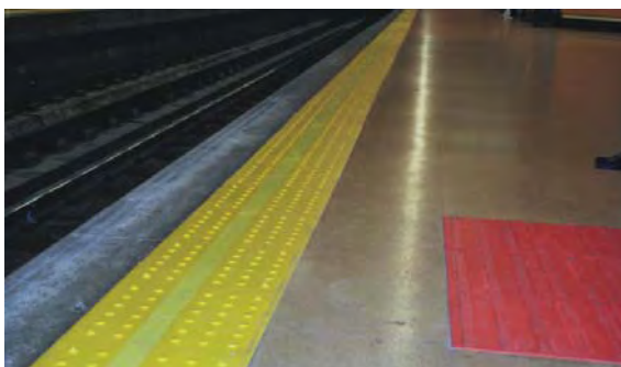
Figura 65. Pavimento de botones o tetones para señalar el borde de andén de una estación de metro. Fuente: Socytec (fotografía).
