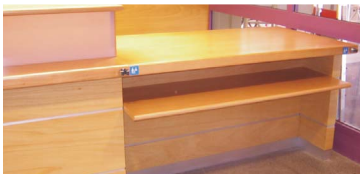
Figura 163. Detalle de un mostrador accesible en un edificio público (vestíbulo del Hospital Universitario de Getafe). Fuente: Socytec (fotografía).
