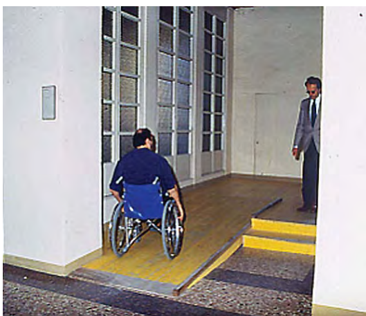
Figura 314. Rampa sencilla en madera en un edificio de carácter histórico. Fuente: Socytec (fotografía).
