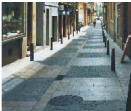
Figura 134. Pavimento contrastado. Fuente: Socytec (fotografía).
