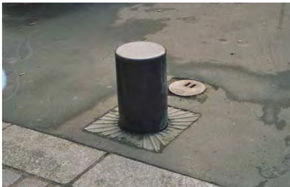
Figura 111. Bolardo retráctil, útil para facilitar el acceso de vehículos de forma selectiva. Es recomendable que tenga una altura mínima de 90 cm y que tengan color contrastado en la parte superior del fuste. Fuente: Socytec (fotografía).
