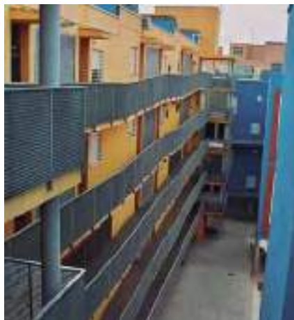
FIG. 02 Ejemplo de buena práctica. Determinadas arquitecturas saben conjugar con acierto forma y función, como es el caso del edificio de viviendas que se muestra: espacios diáfanos, ascensores, corredores con rampas de suave pendiente.
