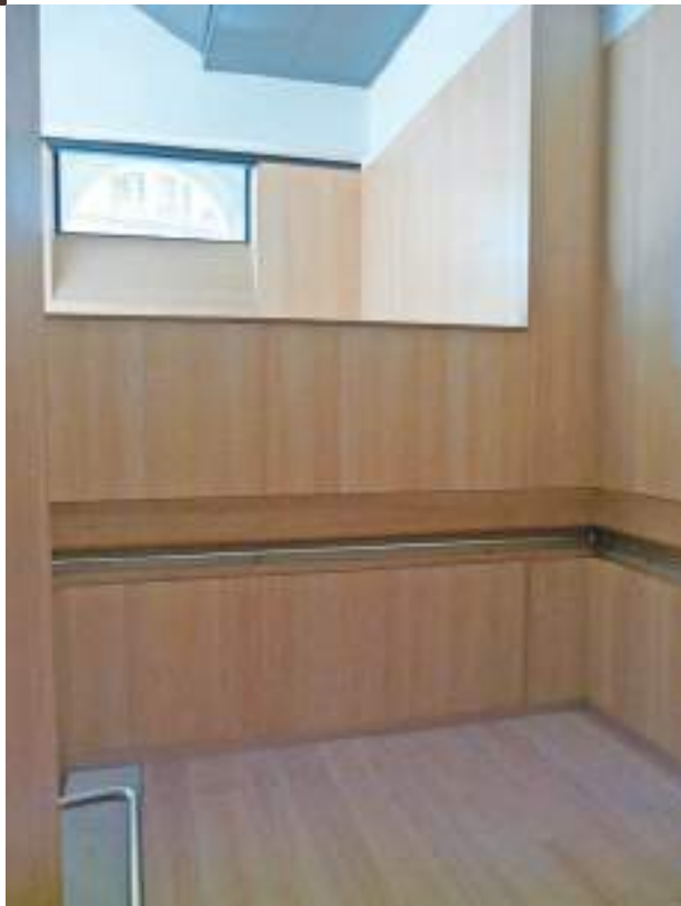
Vista desde el rellano de bajada al sótano.
