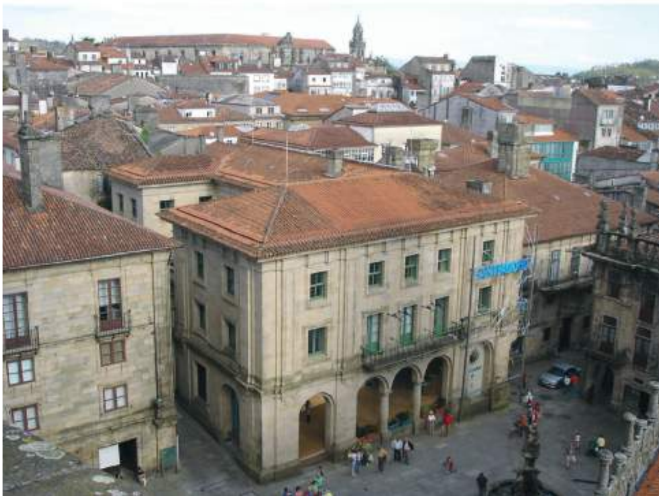
Banco de España. Fachada a plaza de las Platerías. Estado inicial.
