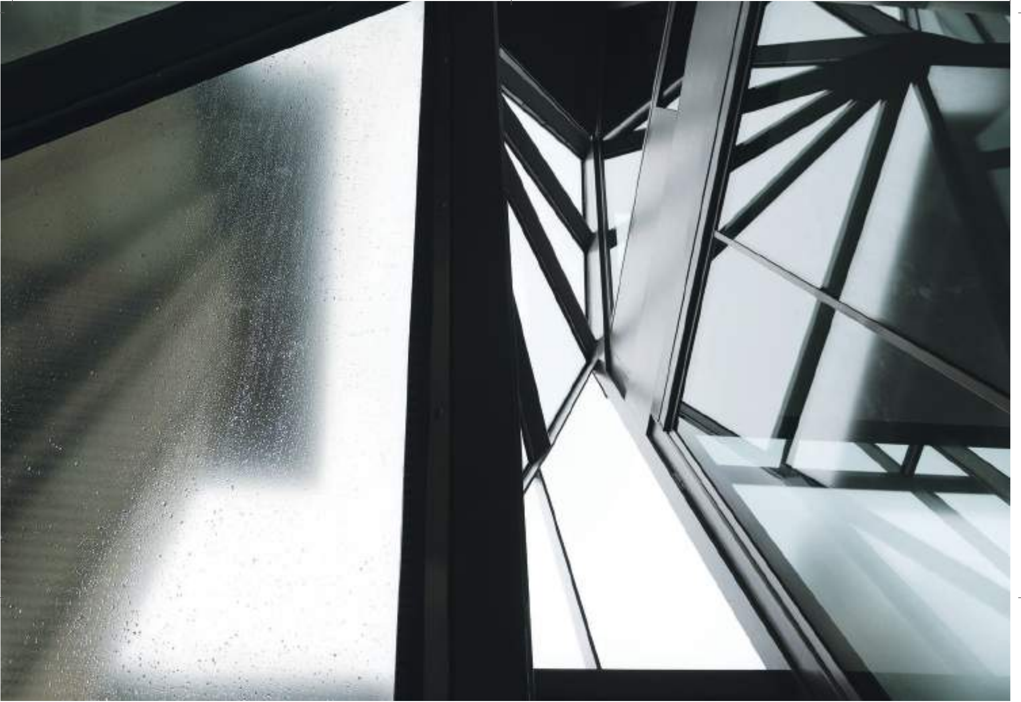
Vistas desde los talleres y cafetería del desdoblamiento de las capas de la fachada acristalada.
