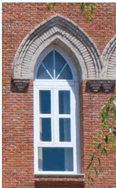
Neogótico de ladrillo: ventanas del colegio Fundación Caldeiro.
