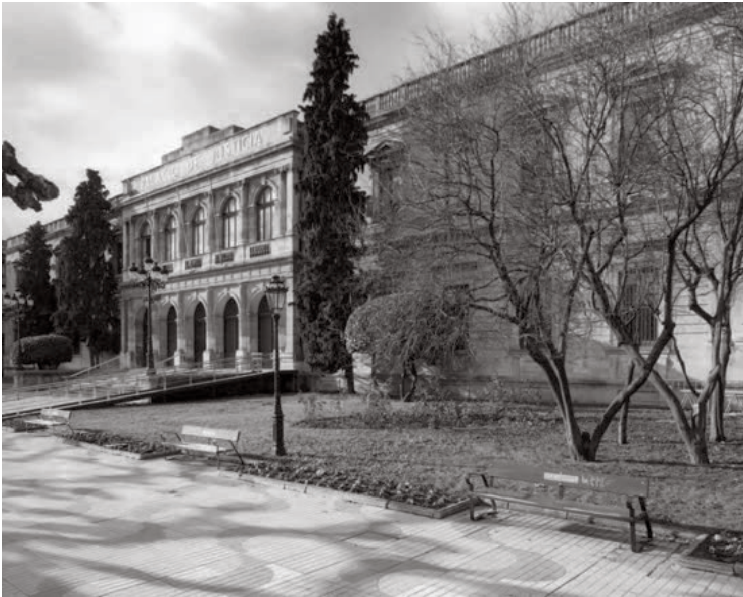
El edificio antes del comienzo de las obras.
