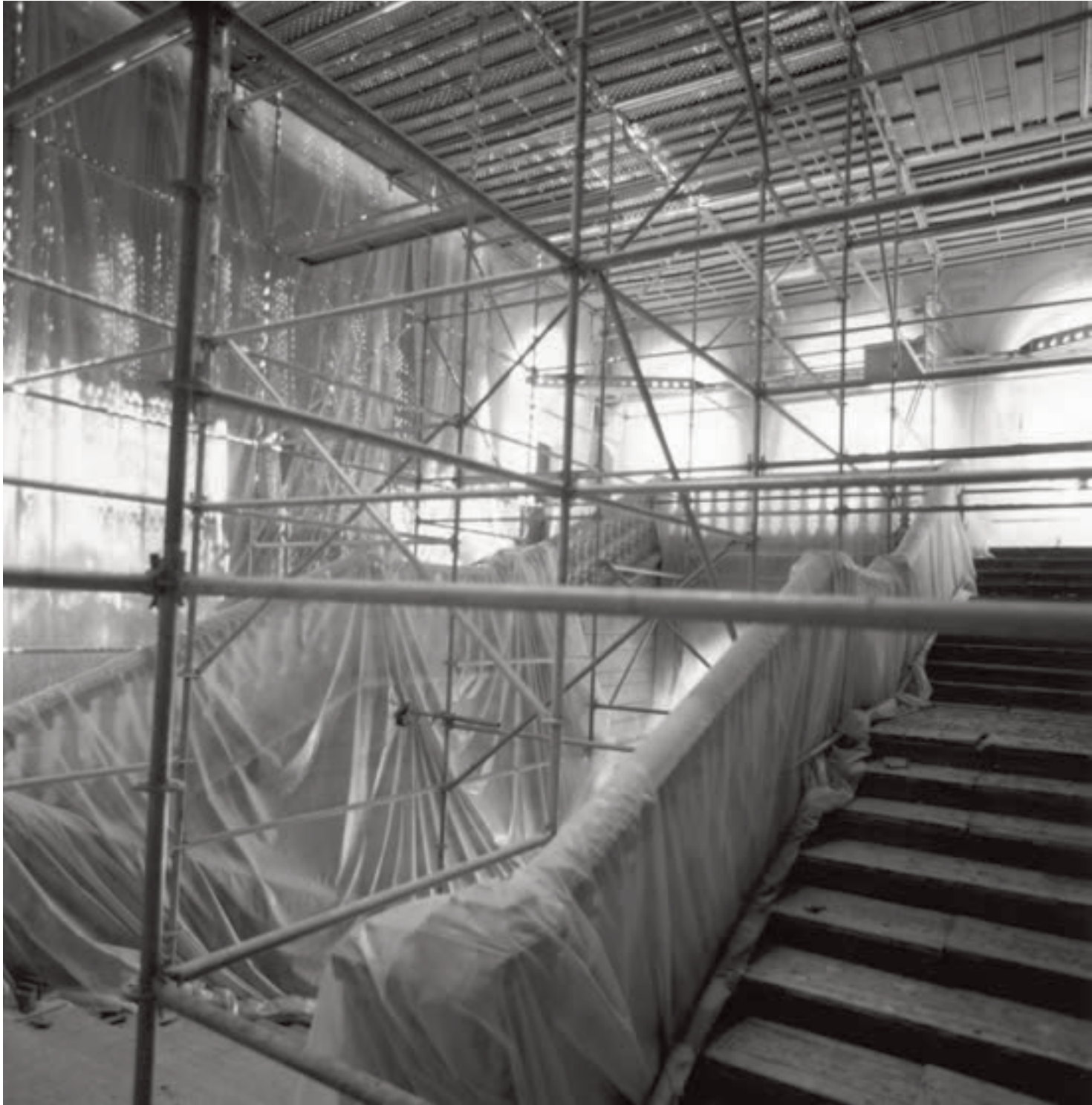
La escalera imperial durante los trabajos de rehabilitación.
