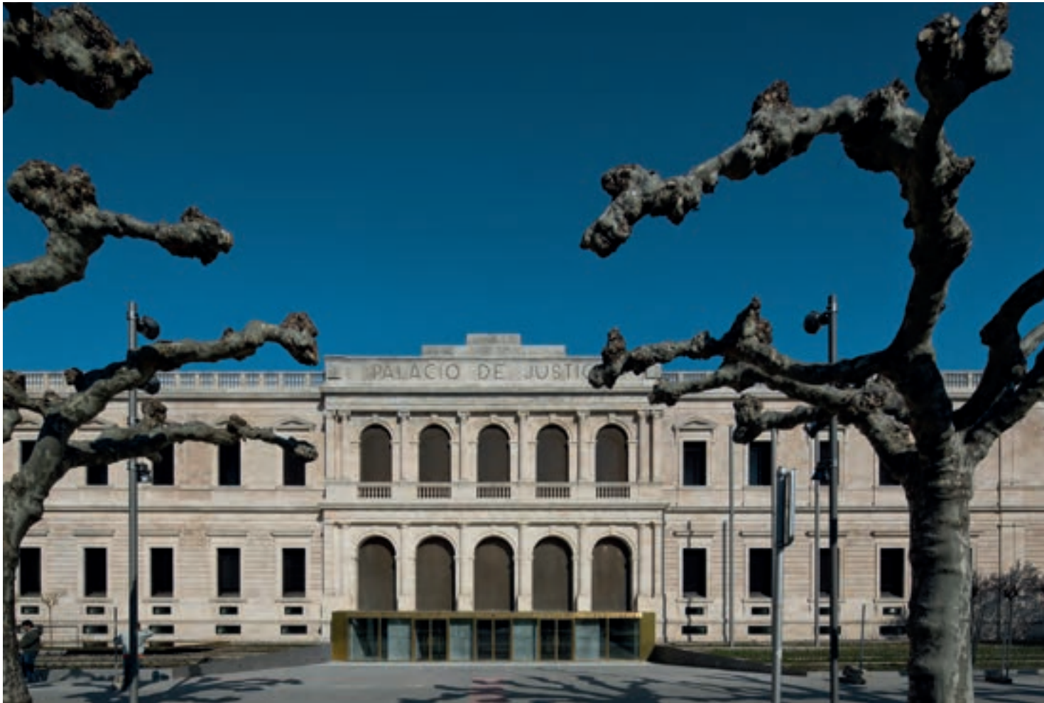
Vistas de la fachada principal del edificio rehabilitado.
