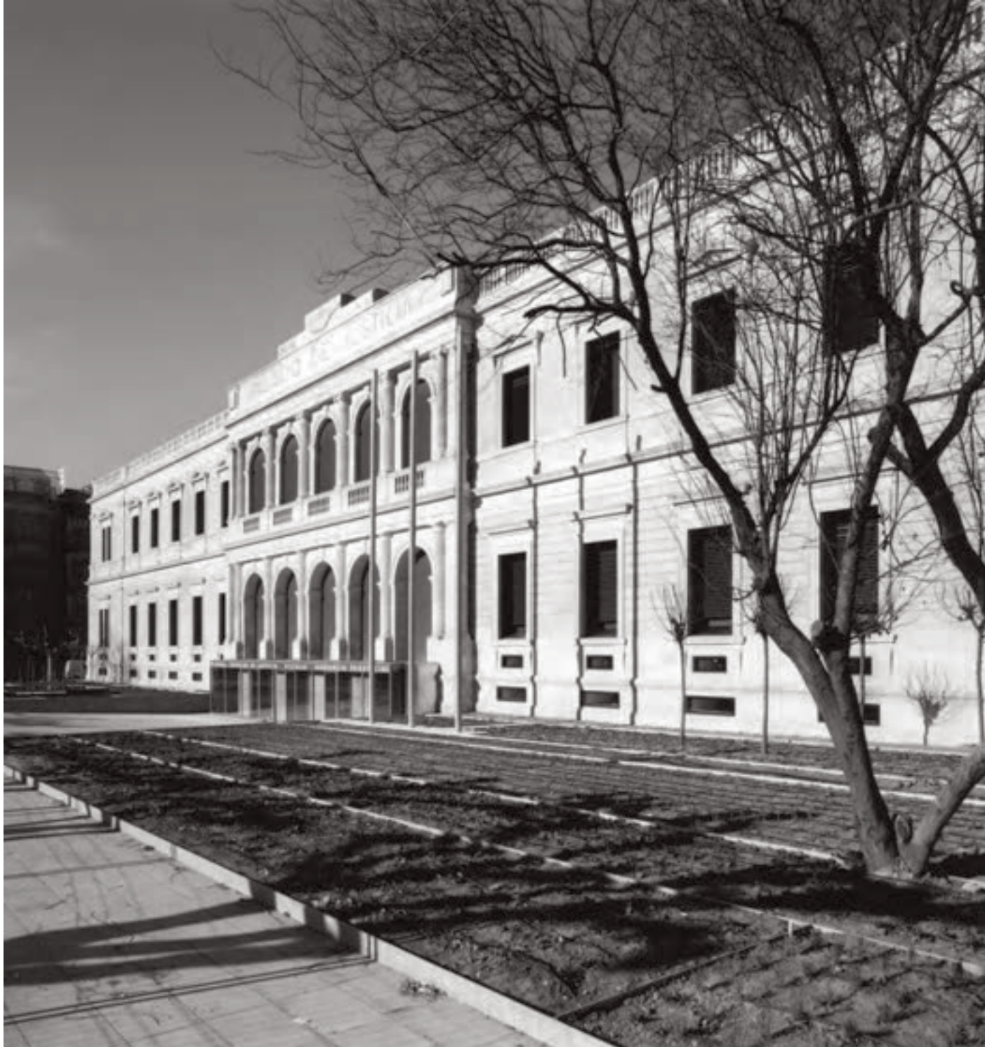
Fachada al finalizar las obras de rehabilitación.
