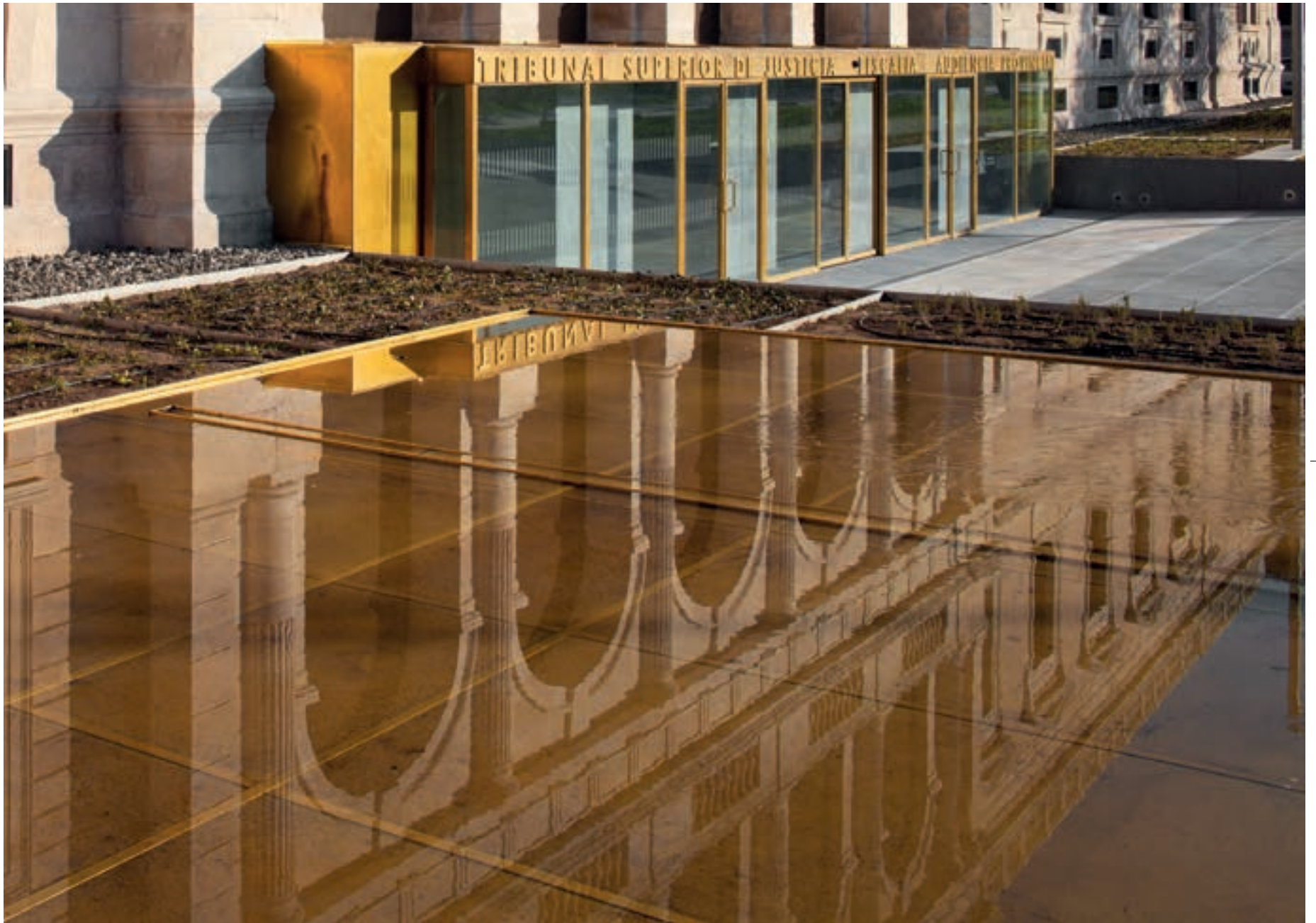
Nuevo acceso y lámina de agua. En página anterior: detalles de la fachada principal del edificio rehabilitado.
