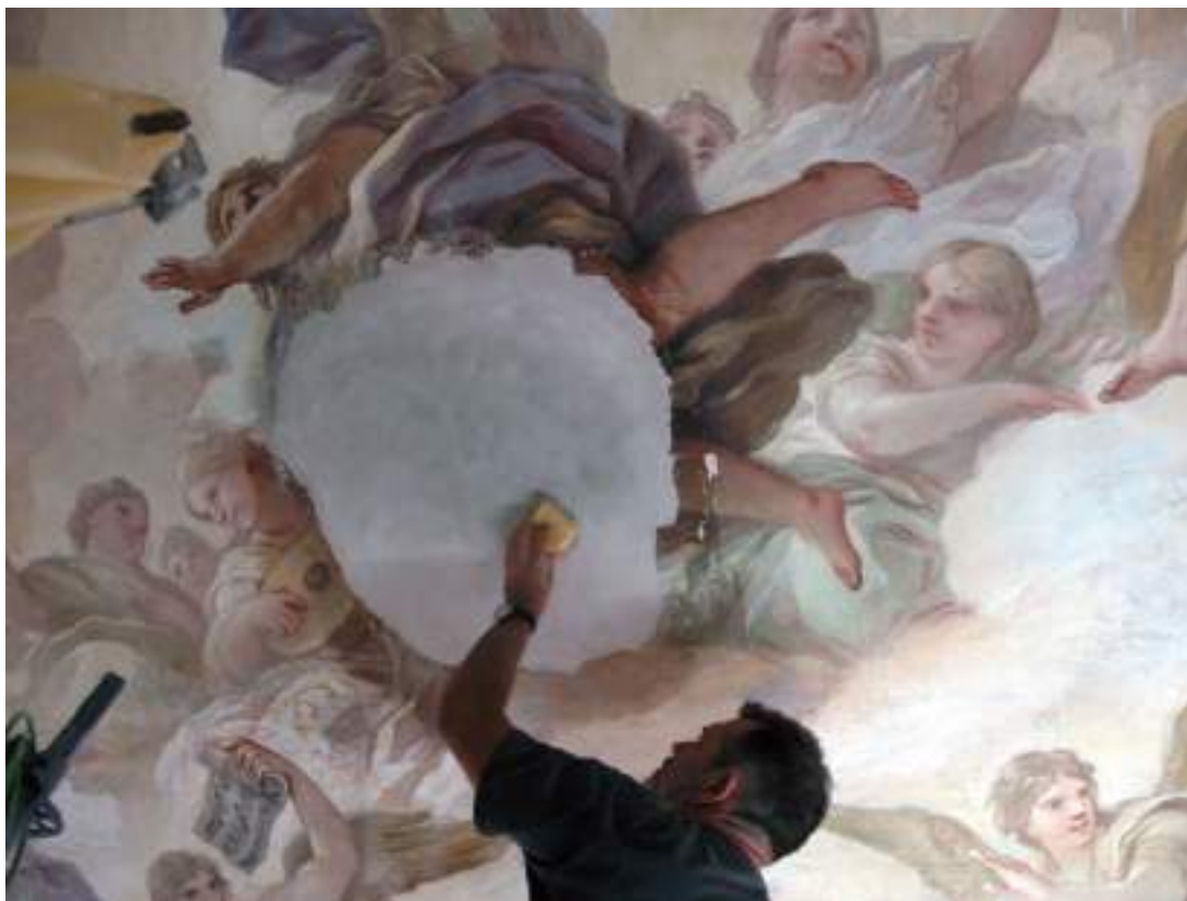
Integración matérica de las faltas de morteros de preparación y pruebas de estucado.
